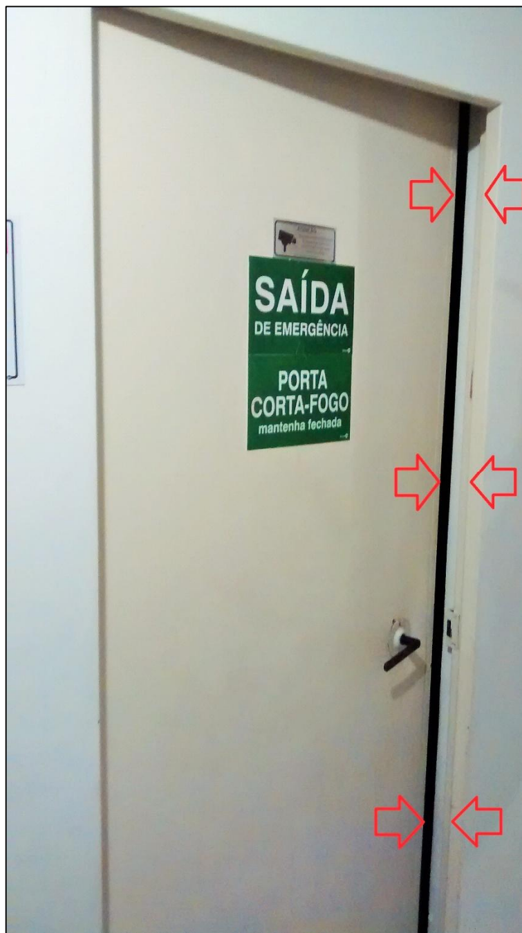
Figura 34 – PCF após testes de verificação de fechamento total
