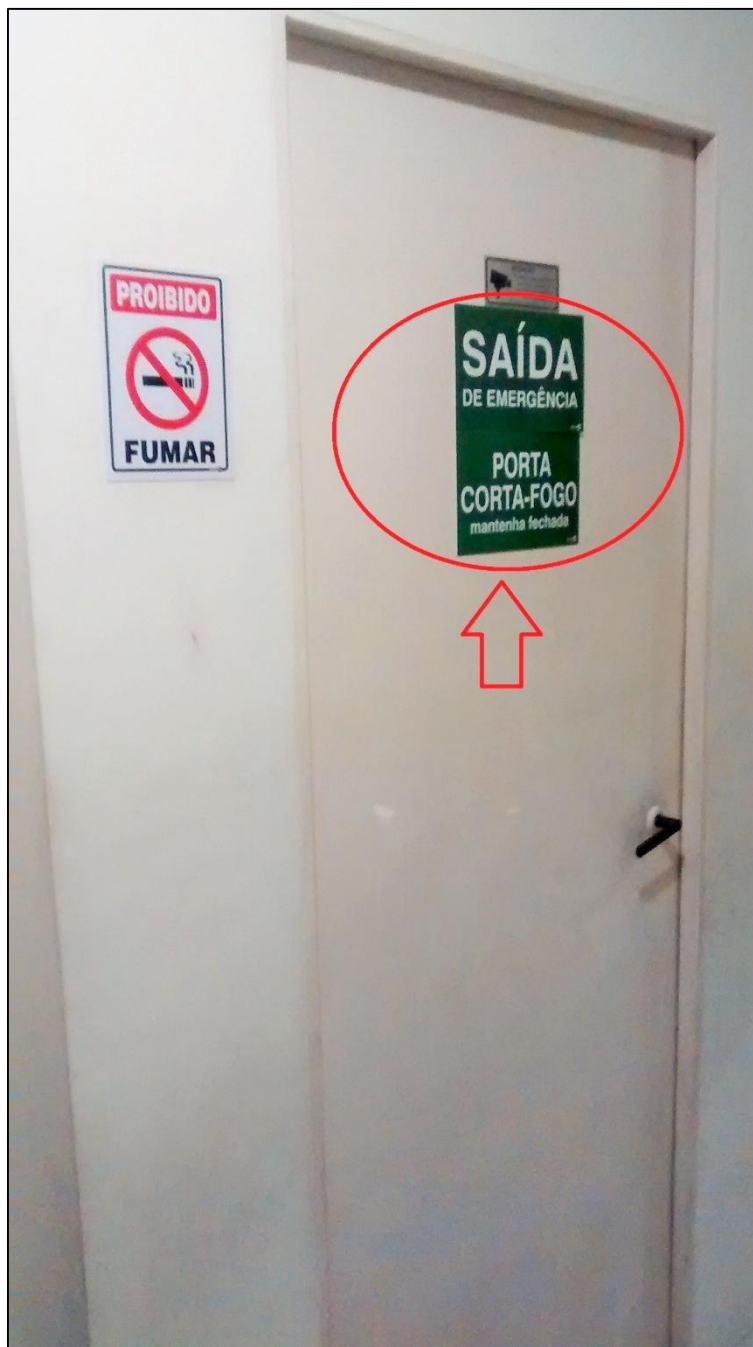
Figura 28 – Identificação de saída de emergência e de PCF
