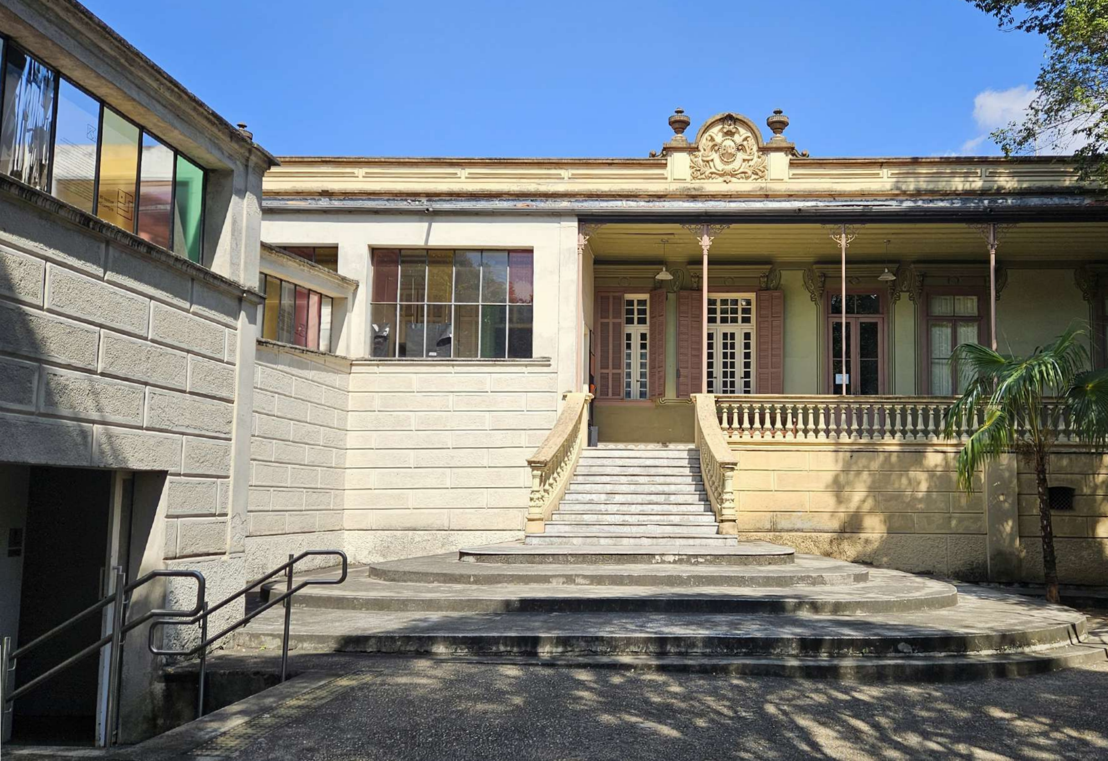
Fachada norte da Casa de Dona Yayá. Fonte: Arquivo da autora
