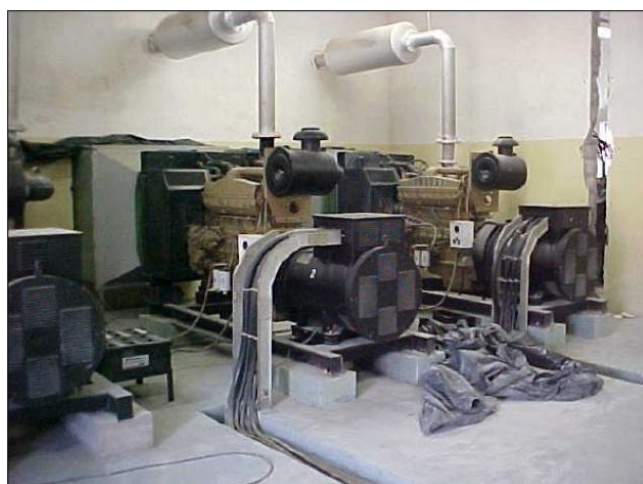
Figura 10 – Sistema centralizado com grupo motogerador
