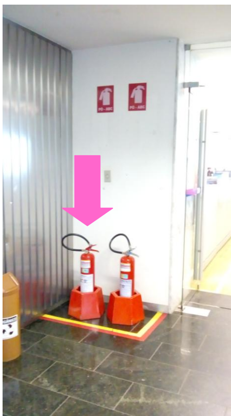
Figura 34 – Extintores de incêndio no pavimento tipo
