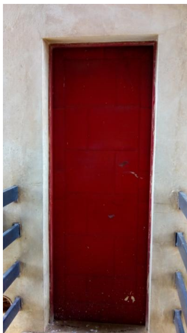
Figura 39 – Porta corta-fogo para acesso à escada de emergência
