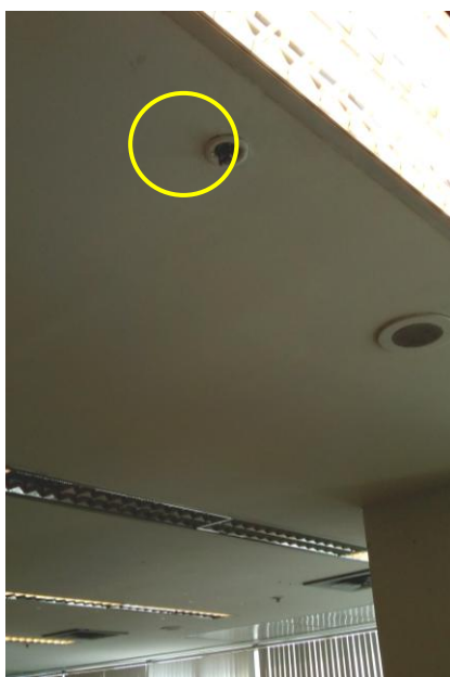
Figura 20 – Chuveiro automático na sala de escritório
