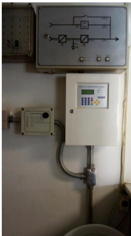
Figura 30 – Central de alarme
