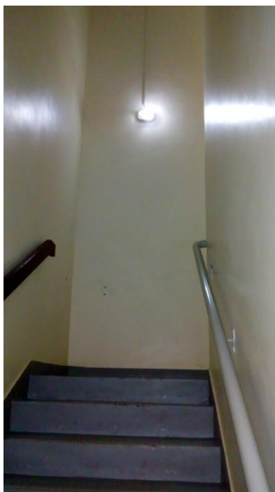
Figura 27 – Iluminação de emergência na escada
