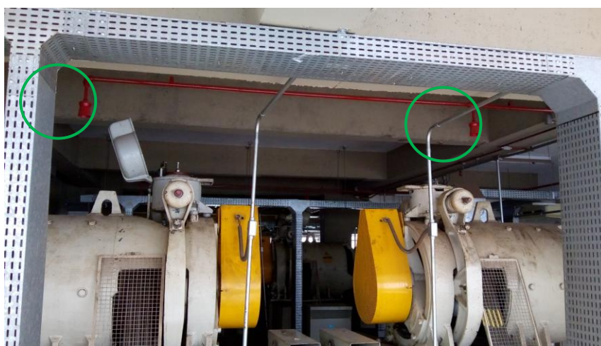
Figura 31 – Sistema fixo automático de proteção contra incêndio com CO 2 no 21º andar
