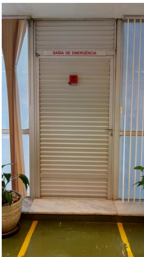
Figura 38 – Porta de alumínio para acesso à passarela
