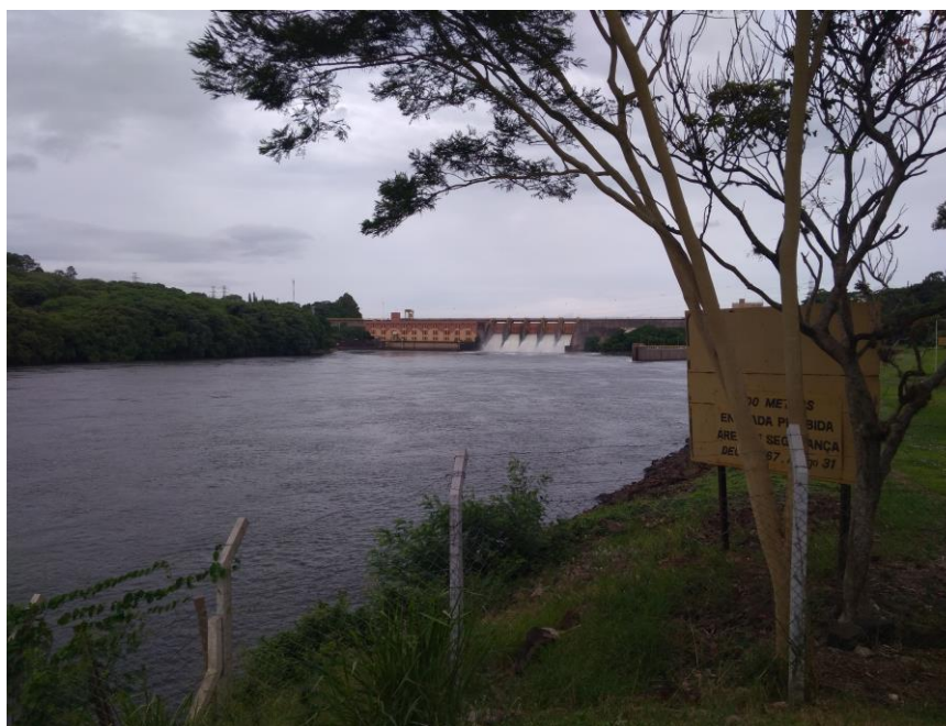
Figura 16 – Fotografia da Usina Hidrelétrica Barra Bonita. Fonte: Arquivo pessoal da autora (2019).
