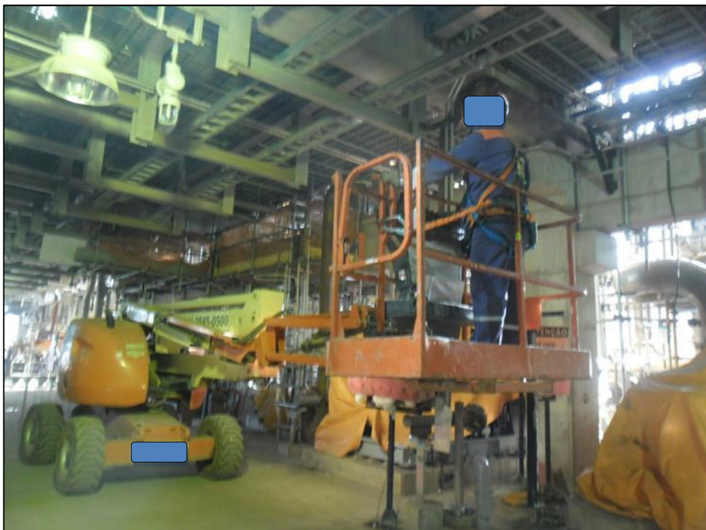
Figura 45: plataforma aérea tipo articulada durante lançamento de cabos. Fonte: Arquivo pessoal, 2012.
