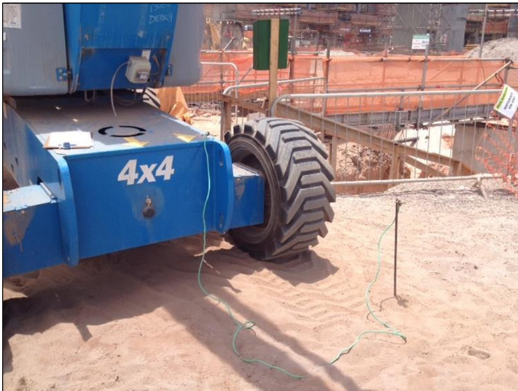
Figura 44: plataforma aérea tipo articulada. Fonte: Arquivo pessoal, 2012.
