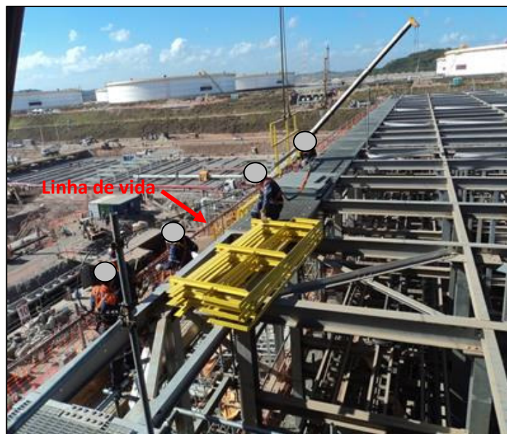
Figura 57: linha de vida com ponto de ancoragem. Fonte: Arquivo pessoal, 2012.
