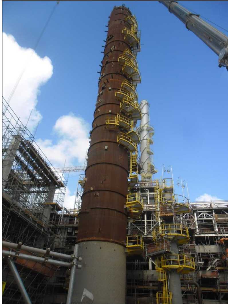
Figura 66: lances de escada com patamares intermediários. Fonte: Arquivo pessoal, 2012.
