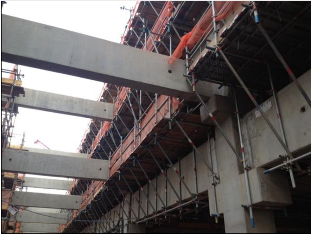
Figura 50: plataformas de tubo roll. Fonte: Arquivo pessoal, 2012.
