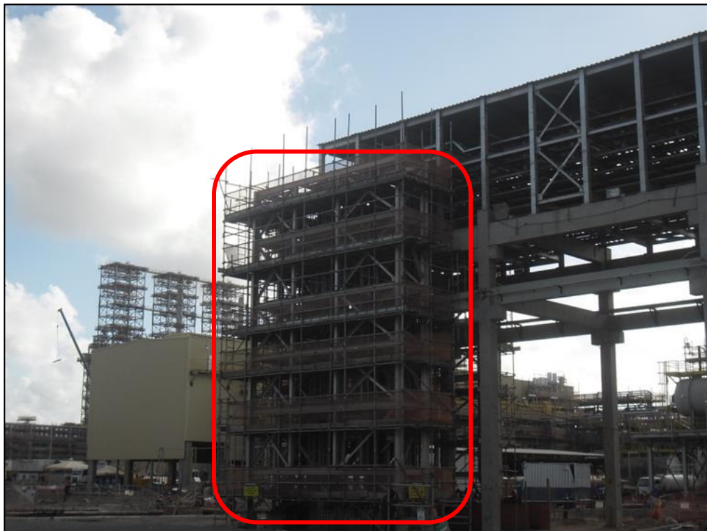
Figura 47: andaimes fixados no Cable Rack. Fonte: Arquivo pessoal, 2012.
