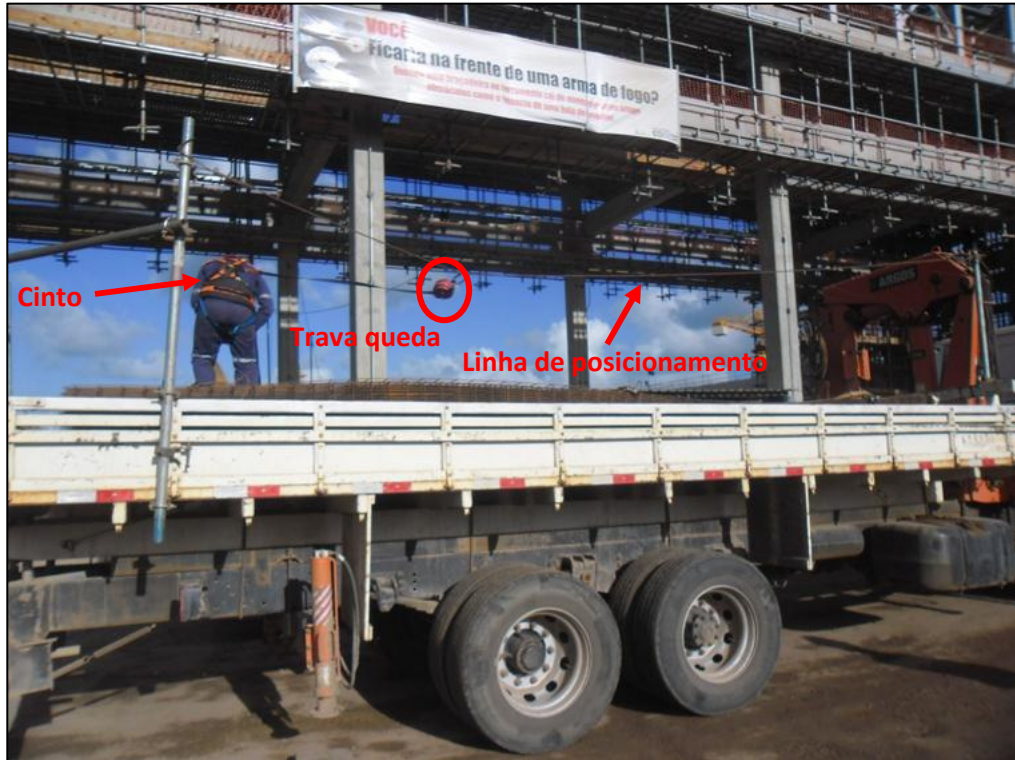
Figura 59: linha de posicionamento em caminhão Munck. Fonte: Arquivo pessoal, 2012.
