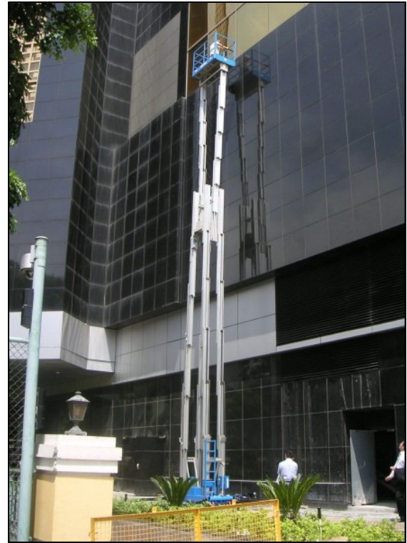
Figura 15: modelo de plataforma multi mastro. Fonte: Lematt, 2012.
