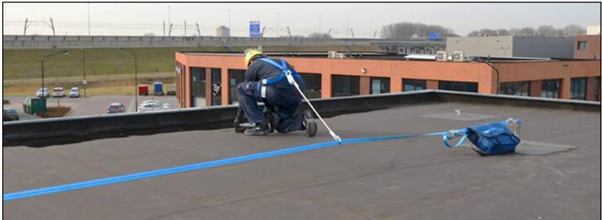
Figura 25: exemplo de linha de posicionamento. Fonte: XS-Platforms, 2012.
