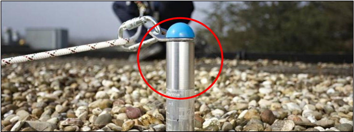
Figura 30: exemplo de ponto de ancoragem. Fonte: XS-Platforms, 2012.
