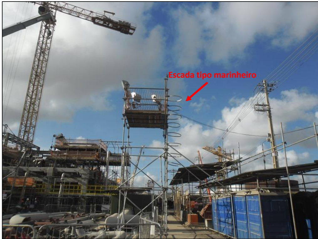
Figura 67: escada tipo marinheiro. Fonte: Arquivo pessoal, 2012.
