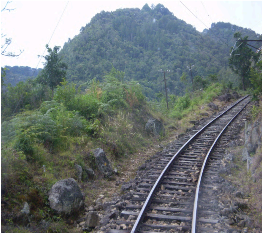
Figura 17 - Trecho da EFCJ com inclinação de 11%, sem uso de cremalheira. A imagem representa aproximadamente 2 metros de altura sendo superados em 20 metros de ferrovia, em escala aproximada da imagem. Fonte: Wikipedia
