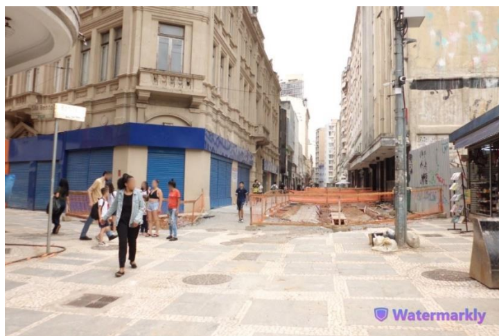
Figura 3 – Trecho da Rua José Bonifácio que encontra a Praça do Ouvidor e a Rua São Bento. Arquivo Pessoal
