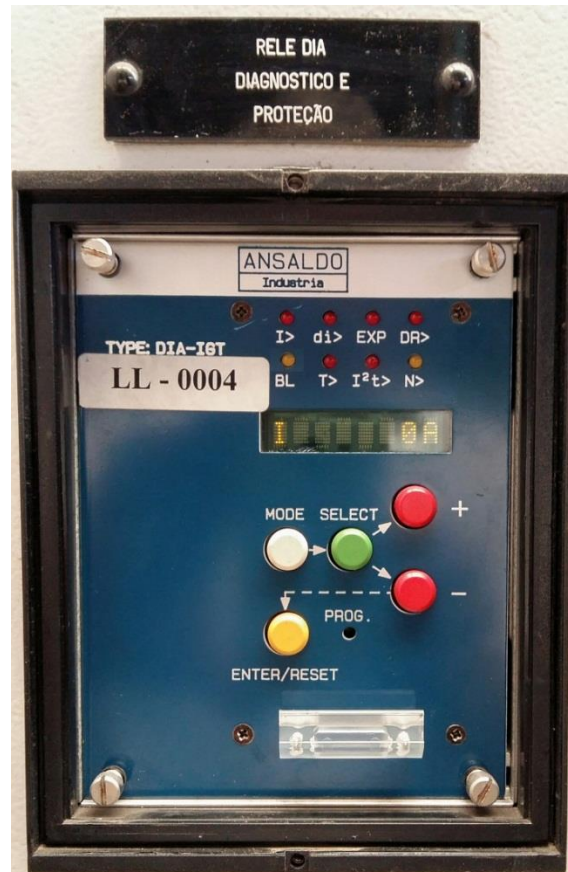
Figura 15 - Módulo de análise Dia-IGT - Relé Dia.
