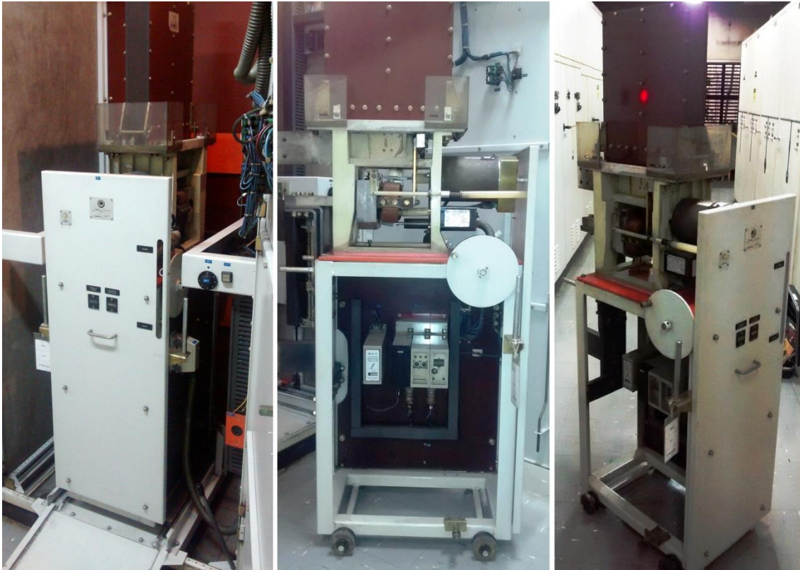
Figura 12 - Feeder em posição de teste, extraído e fora do cubículo.
