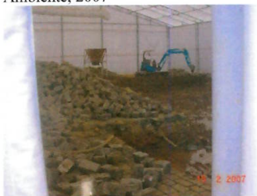
Figura 4: Escavação de solo contaminado por pesticidas, realizada sob tendas. Fonte: Secretaria do Verde e do Meio Ambiente, 2007
