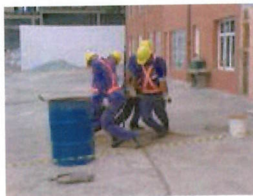
Figura17: Perfuração de sondagem a trado manual.
