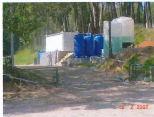
Figura 3: Estação de tratamento de efluentes da barreira hidráulica. Fonte: Secretaria do Verde e do Meio Ambiente, 2007
