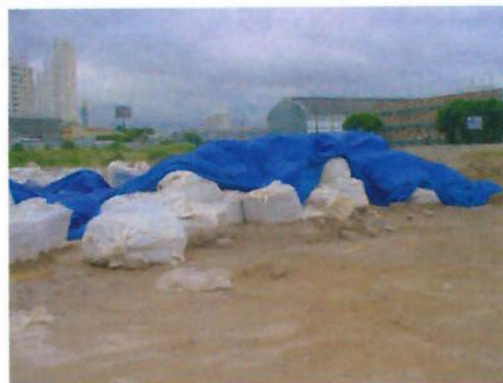
Figura 7: "Big bags" contendo solo contaminado armazenado para disposição adequada. Fonte: Secretaria do Verde e do Meio Ambiente, 2007
