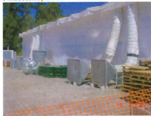
Figura 5: Vista externa da Tenda de escavação com sistema de exaustão. Fonte: Secretaria do Verde e do Meio Ambiente, 2007
