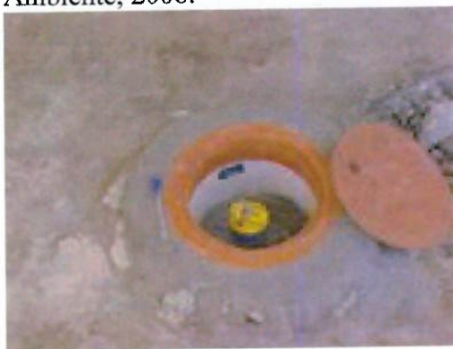
Figura 18: Poço de monitoramento instalado e lacrado.
