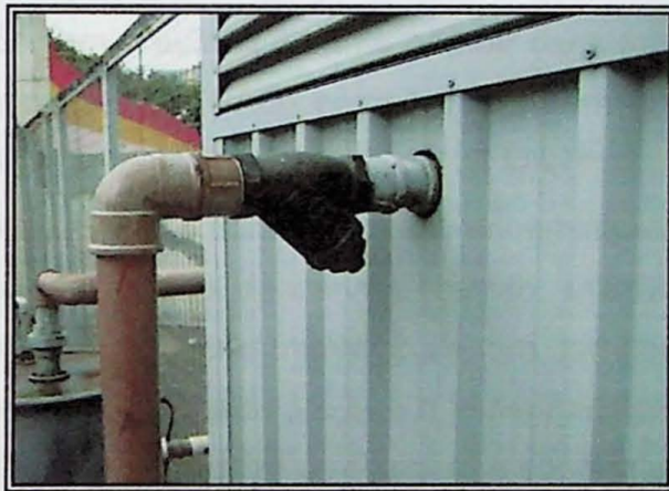
Foto 2a – Entrada do sistema com filtro "Y";
