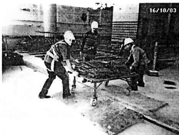
Figura 5.12 – Transporte horizontal de armaduras com a utilização de um carrinho
