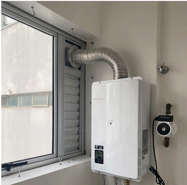
F.85 Aquecedor depois da obra
