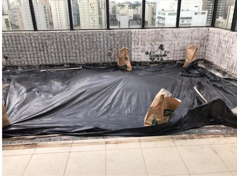
F.34 Proteção da varanda em dia de chuva
