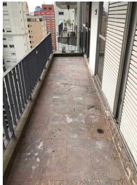
F.41 Remoção de revestimentos de piso das varandas dos quartos
