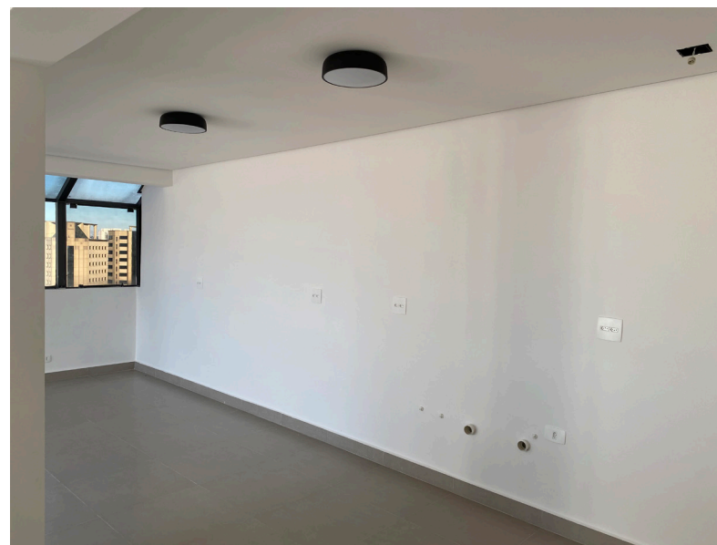
F.46 Infraestrutura hidráulica cozinha gourmet
