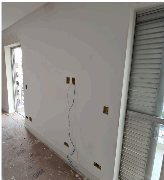
F.68 Foto depois do tratamento das paredes da suíte
