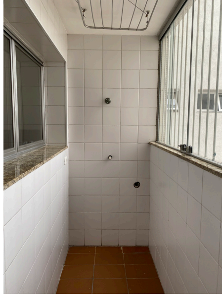
F.90 Lavanderia - visita inicial Pinheiros
