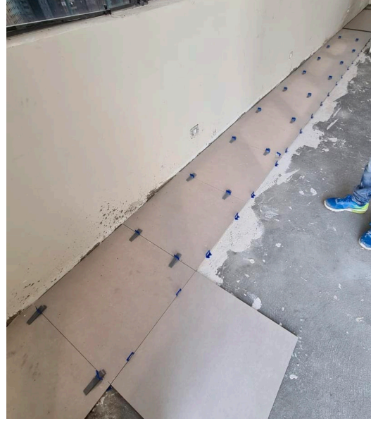
F.63 Instalação de Revestimento de Piso na Sala da Cobertura
