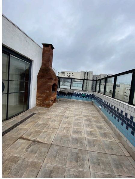
F.26 Varanda Cobertura - visita inicial Moema
