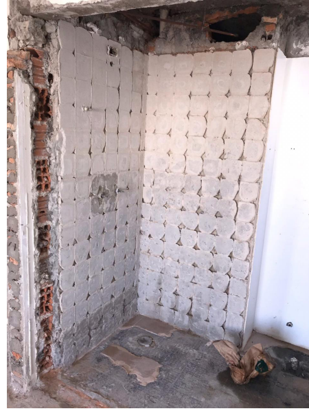
F.37 Remoção de revestimentos e forro banheiro suíte
