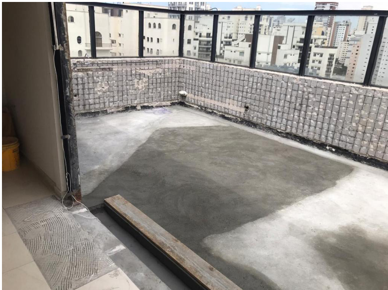
F.54 Varanda cobertura 1
