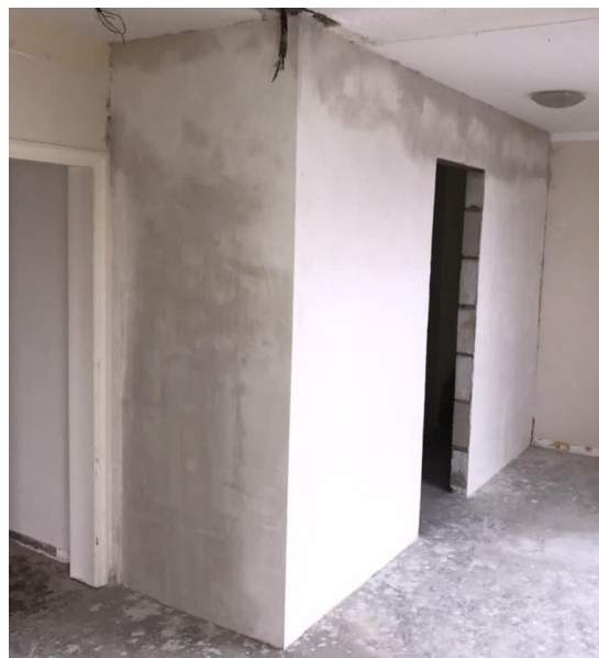
F.71 Pintura de paredes novas
