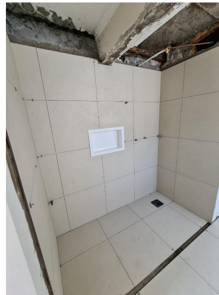
F.58 Instalação de Revestimento no Banheiro da Suíte
