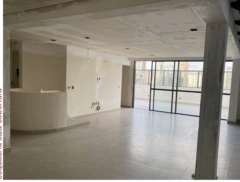
F.44 Instalação de revestimentos, execução novo forro, acabamento pilares e instalação da nova esquadria sala cobertura
