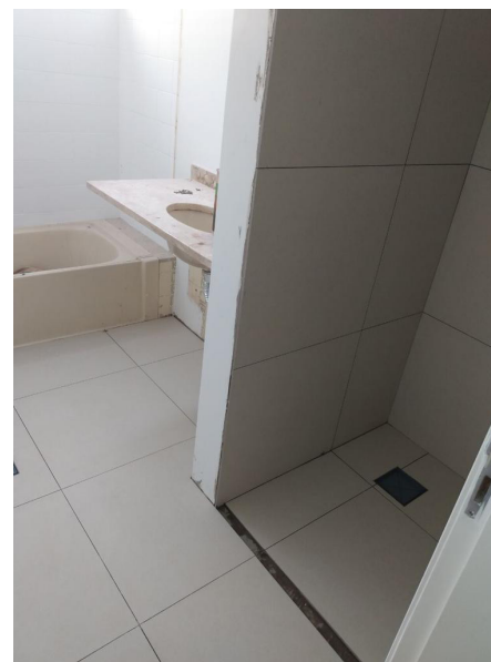
F.59 Instalação de Revestimento no Banheiro do corredor
