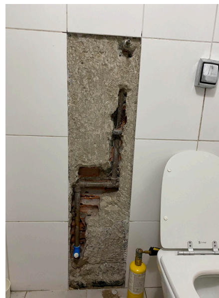
F.103 Execução infraestrutura de hidráulica Banheiro Corredor
