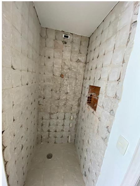
F.38 Remoção de revestimento e abertura de nicho banheiro corredor
