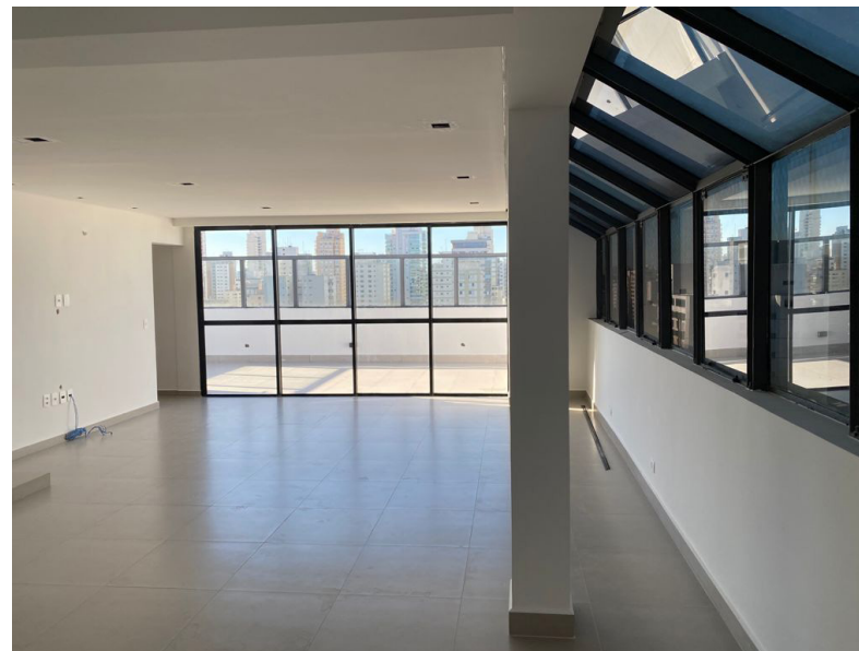
F.74 Pintura de forro
