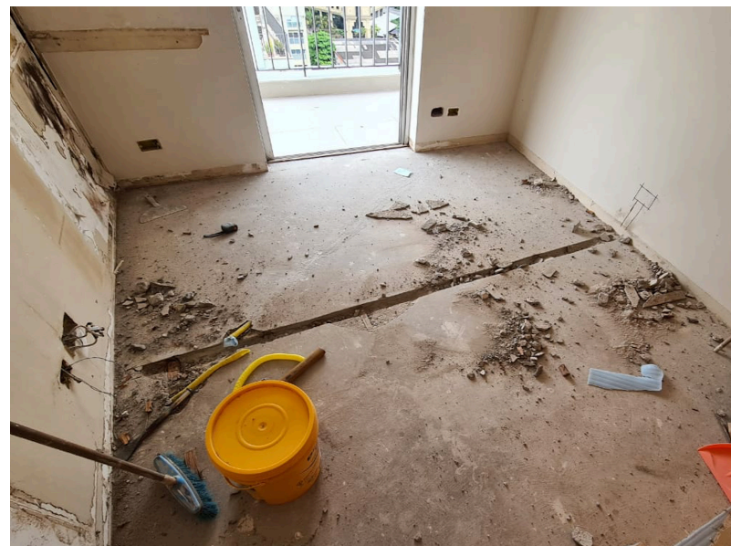
F.50 Execução de infraestrutura de elétrica para novos pontos de tomada
