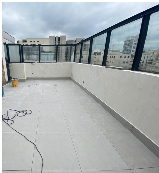
F.72 Pintura de paredes externas
