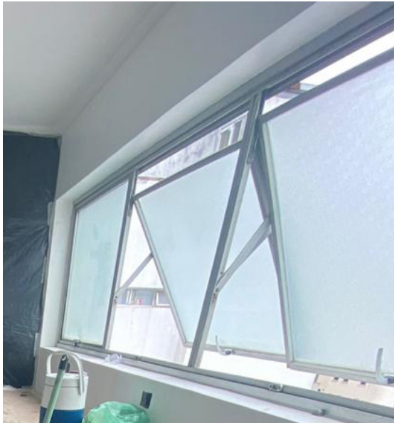
F.82 Janelas antes da obra
