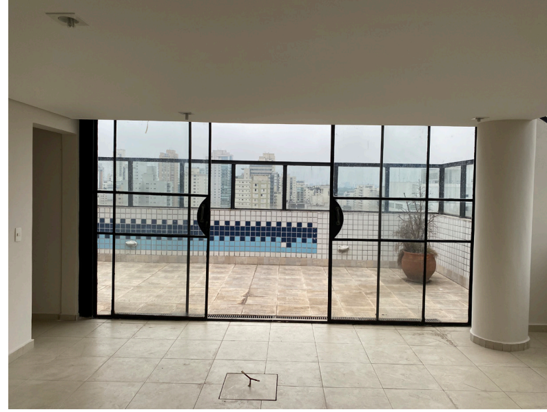
F.28 Sala 2 Cobertura - visita inicial Moema
