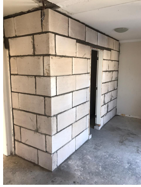
F.36 Ampliação banheiro da suíte
