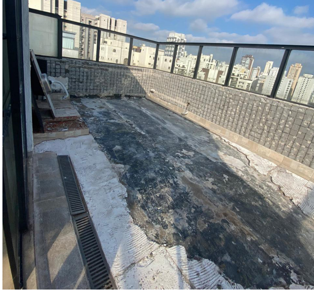
F.42 Remoção de revestimento e remoção de churrasqueira varanda cobertura
