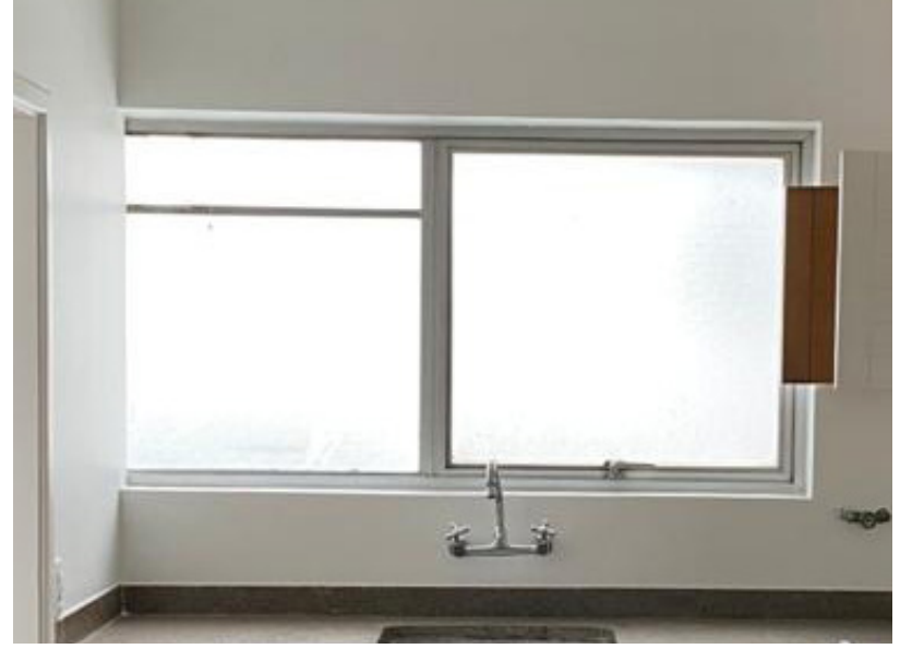
F.80 Janela cozinha antes da obra
