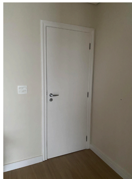
F.77 Porta suíte instalada
