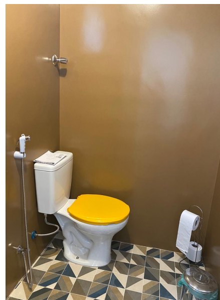
F.106 Instalação de revestimento de piso
