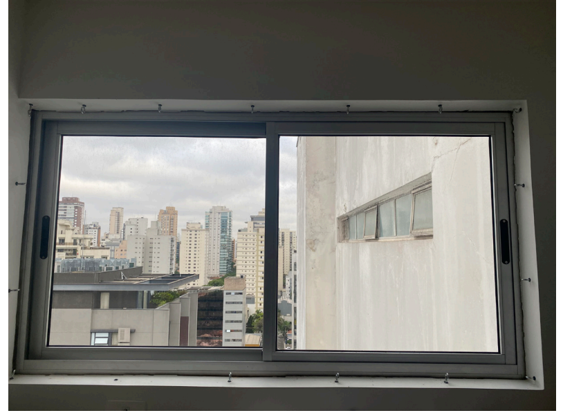
F.81 Janela cozinha depois da obra
