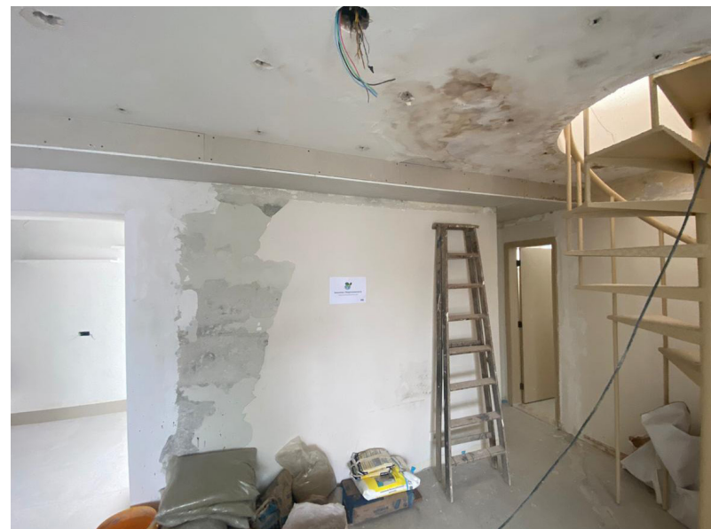
F.65 Foto antes do tratamento das paredes da sala
