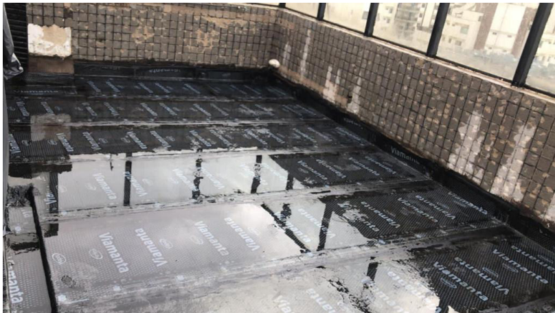
F.55 Varanda cobertura 2
