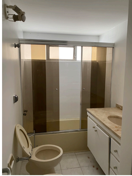
F.18 Banheiro Corredor - visita inicial Moema
