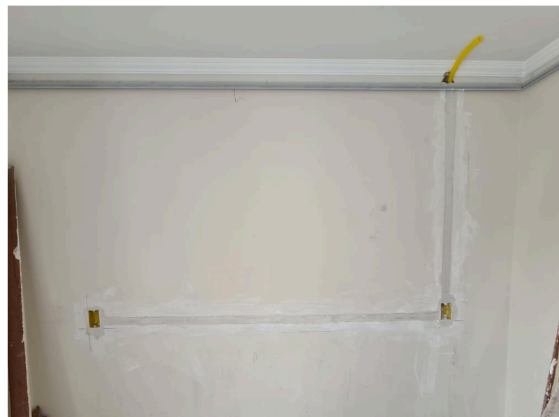
F.51 Execução de infraestrutura de elétrica para novos pontos de interruptores
