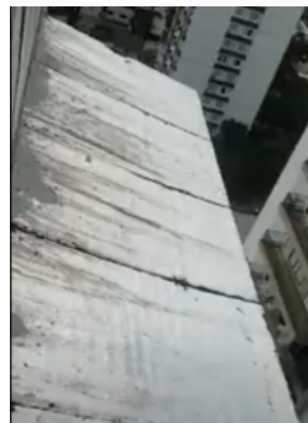
F.53 Vista de cima da laje de cobertura das varandas dos quartos
