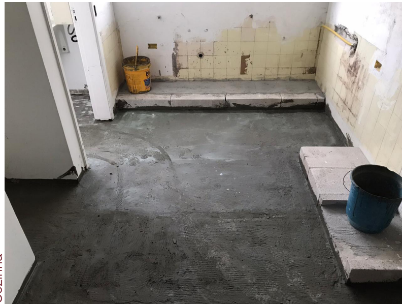
F.40 Remoção de revestimento de piso, manutenção contrapiso e construção de base de alvenaria Cozinha
