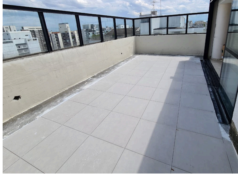
F.62 Instalação de Revestimento de Piso na Varanda da Cobertura
