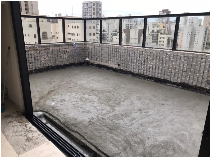
F.57 Varanda cobertura 4
