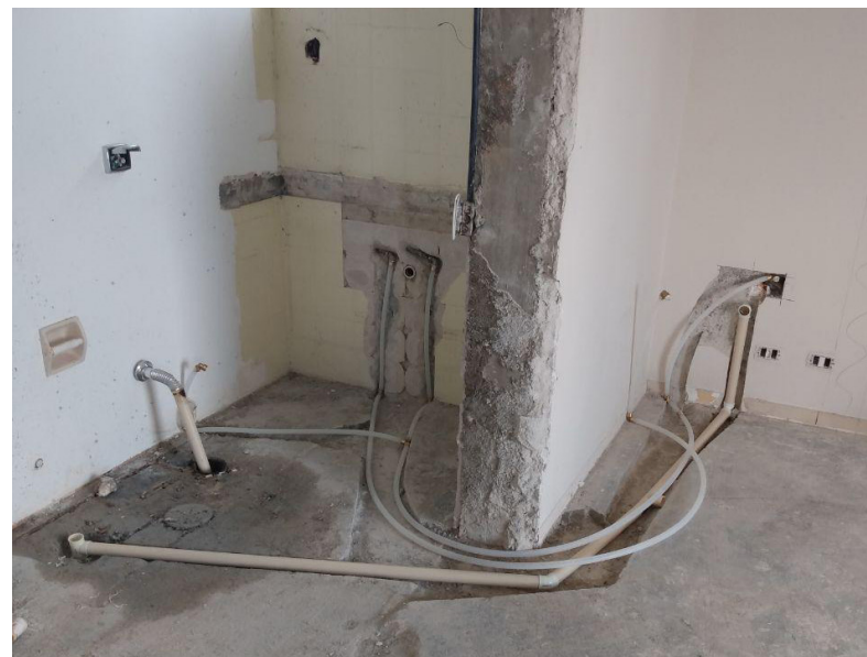
F.45 Infraestrutura hidráulica banheiro da suíte
