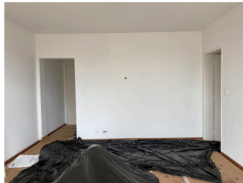
F.100 Proteção para demolição
