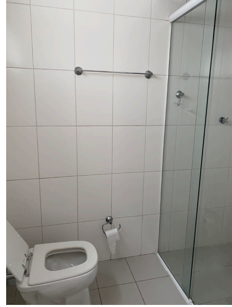
F.92 Banheiro Corredor - visita inicial Pinheiros
