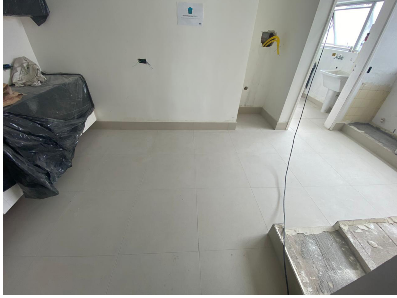
F.60 Instalação de Revestimento de piso na cozinha e lavanderia
