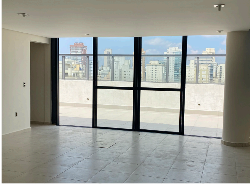
F.78 Esquadria de antes da obra
