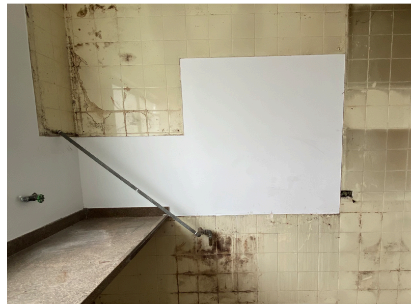
F.48 Antiga tubulação externa de gás
