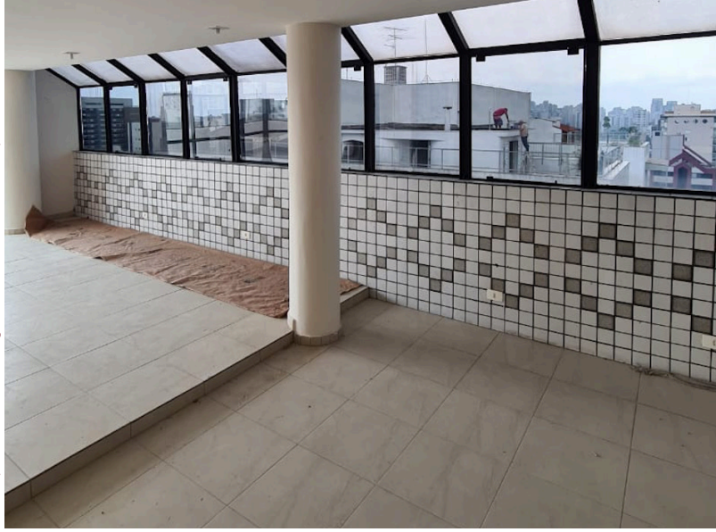
F.43 Remoção de revestimentos, remoção de forro, remoção de revestimentos dos pilares e retirada de esquadria entre sala e varanda sala cobertura (foto da situação antes da obra)
