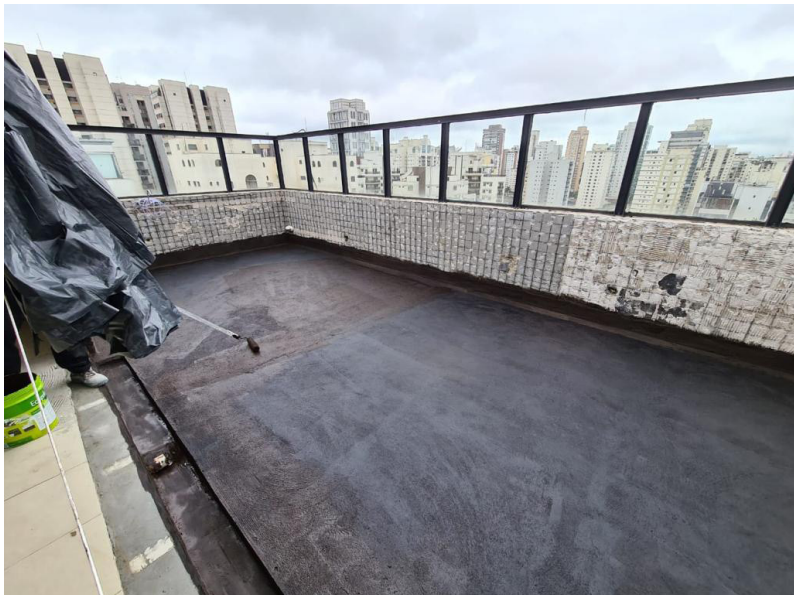
F.56 Varanda cobertura 3
