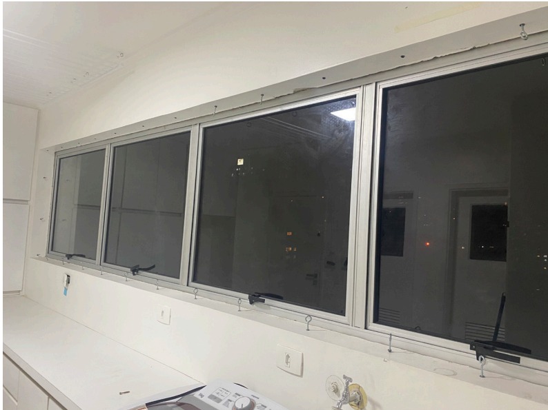
F.84 Janelas depois da obra
