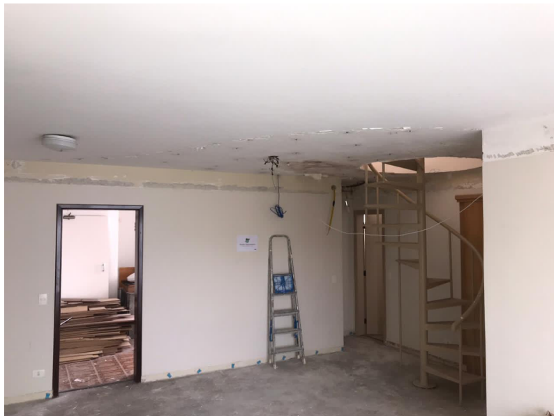
F.39 Remoção de revestimento e forro/sanca da sala
