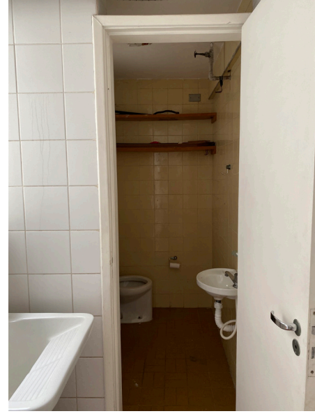
F.91 Banheiro Social - visita inicial Pinheiros
