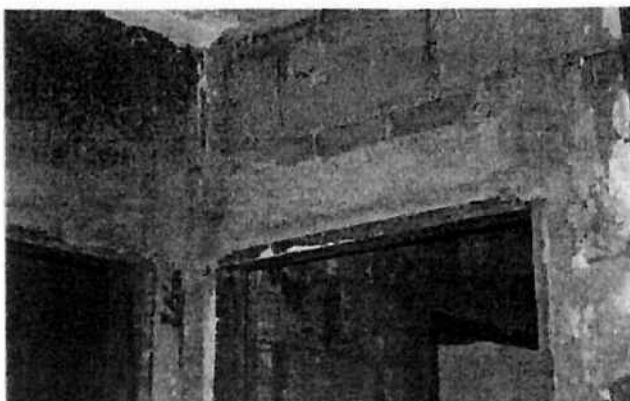
Foto 9 – Verga proposta no projeto de alvenaria.
