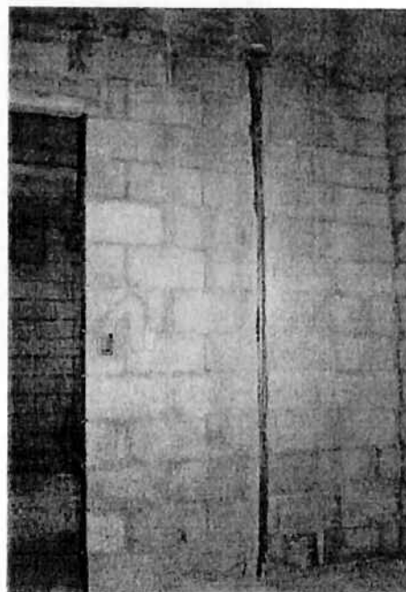
Foto 4 – Solução adotada na obra para o embutimento da tubulação dos drenos.
