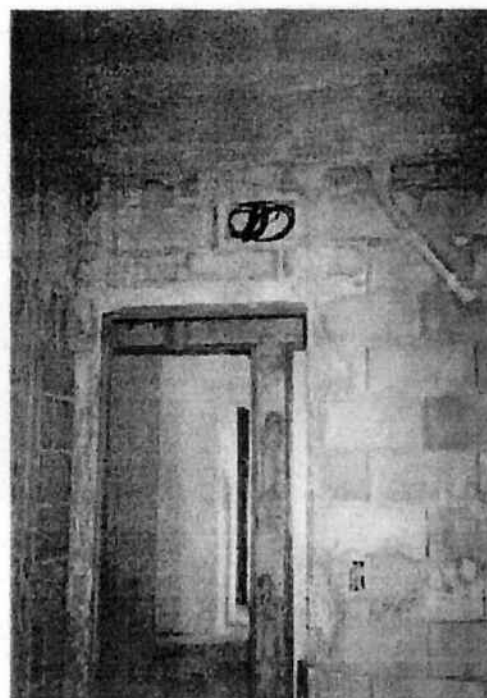
Foto 5 – Solução adotada na obra para a passagem da tubulação de ar condicionado
