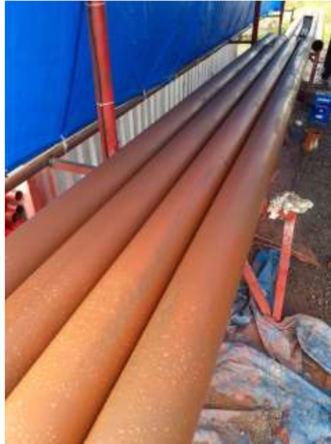
Figura 21 – Pintura dos Tubos (Acabamento e Vermelho)
