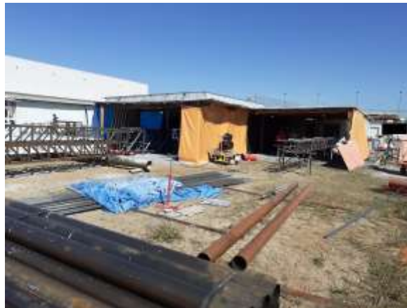
Figura 8 – Canteiro de Obras: Local de Trabalho dos Colaboradores
