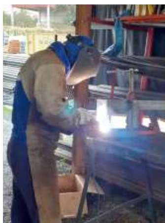
Figura 30 – União das Peças Através da Solda Elétrica
