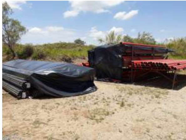
Figura 11 – Canteiro de Obras: Estoque de Tubos (Área Externa do Canteiro)
