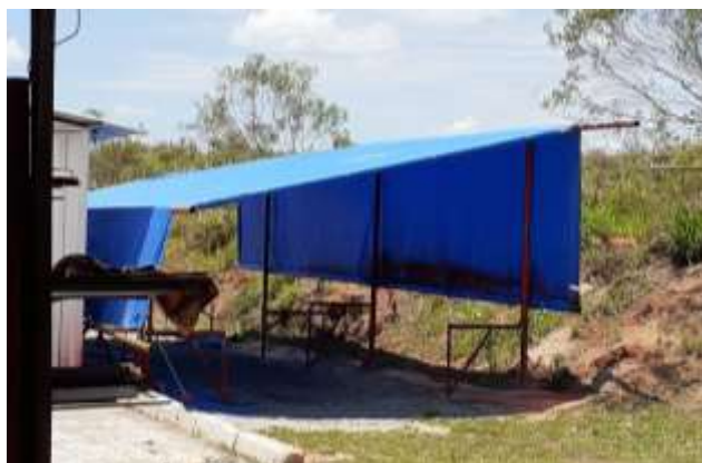
Figura 13 – Canteiro de Obras: Tenda de Pintura
