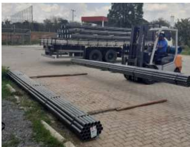
Figura 17 – Chegada de Materiais no Canteiro e Movimentação da Carga
