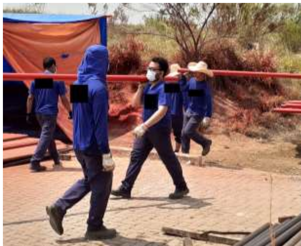
Figura 19 – Movimentação dos Tubos para a Máquina de Ranhura
