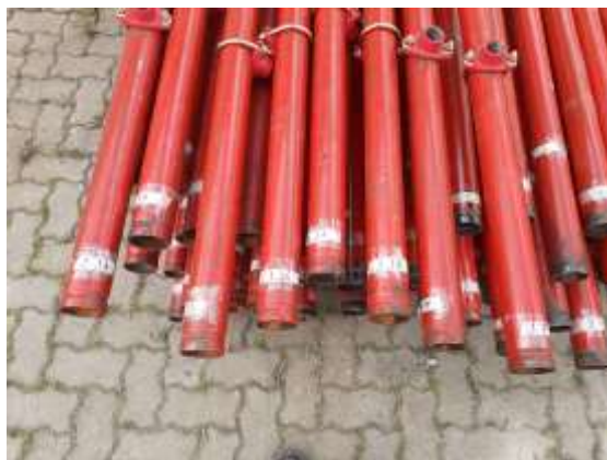
Figura 25 – Marcação de Numeração dos Tubos
