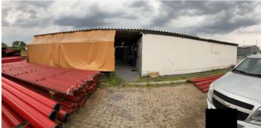
Figura 7 – Canteiro de Obras (Estrutura de Madeira)
