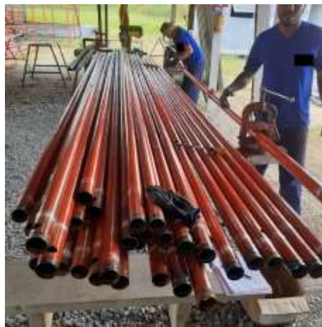
Figura 24 – Colocação e Aperto das Saídas de Sprinklers
