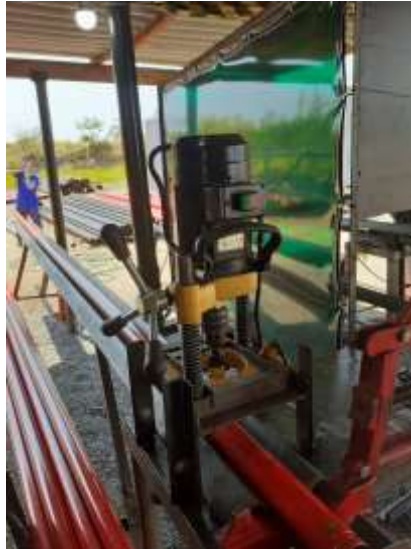
Figura 23 – Local para Furação de Tubos – Máquina de Furar Tubos
