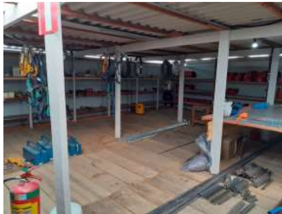
Figura 10 – Canteiro de Obras: Almoxarifado (Dentro do Canteiro)
