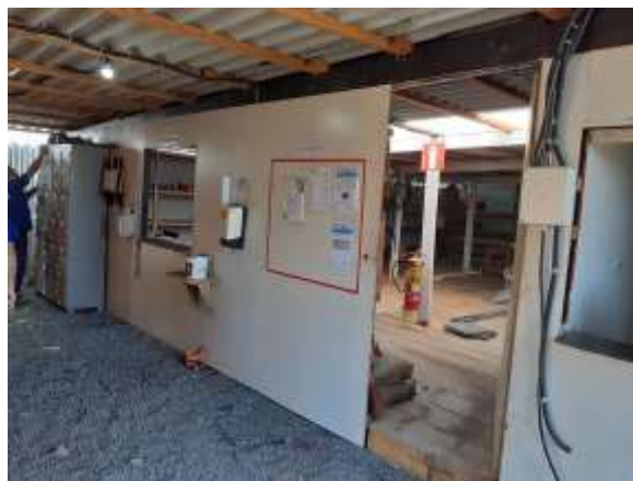
Figura 9 – Canteiro de Obras (Divisão entre Almojarifado e Local de Trabalho)
