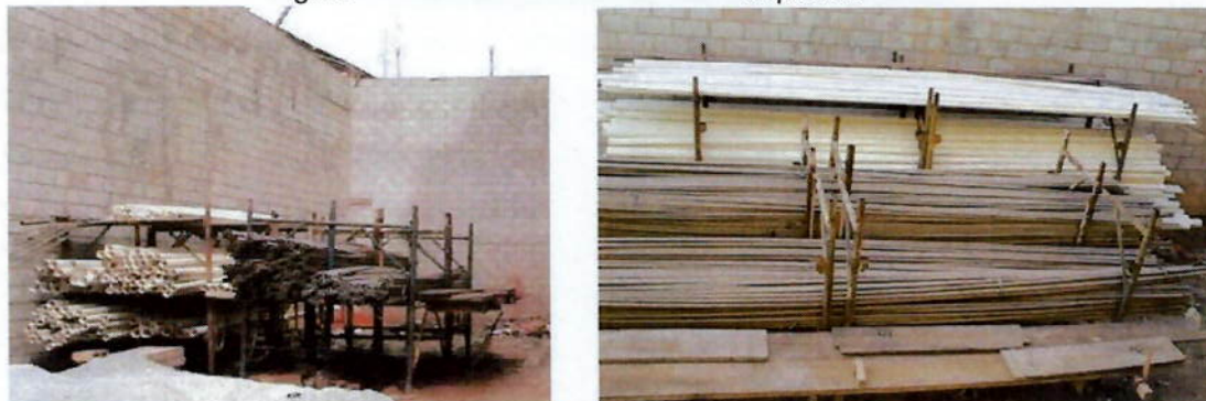
Figura 5 - Armazenamento de tubos expostos ao sol
