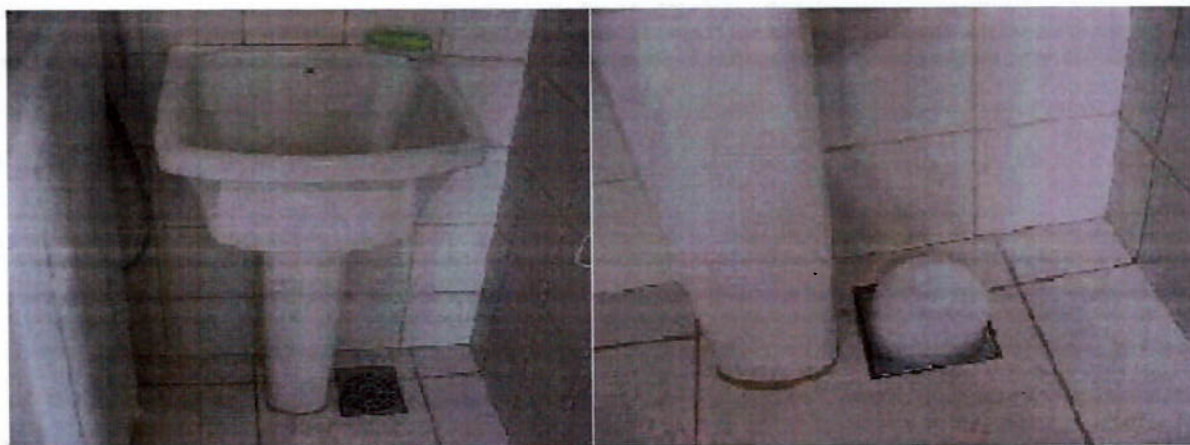
Figura 19 – Retorno de espumas em tubulações de captação de esgoto de tanque e máquina de lavar
