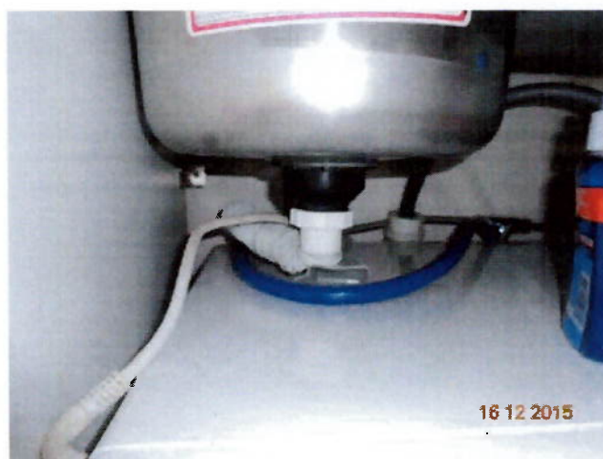
Figura 23 – Sifão esmagado após a instalação de armário
