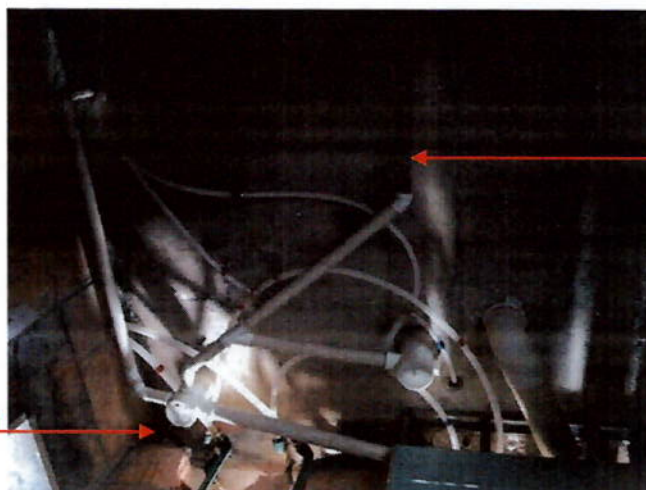
Figura 28 – Aranha de captação de esgoto de banheiro com ligação de dreno de ar condicionado
