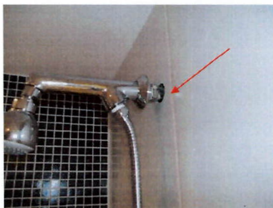
Figura 24 – Ducha instalada com prolongador e com vazamento
