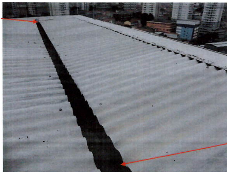
Figura 21 – Calha com declividade invertida ao ponto de captação
