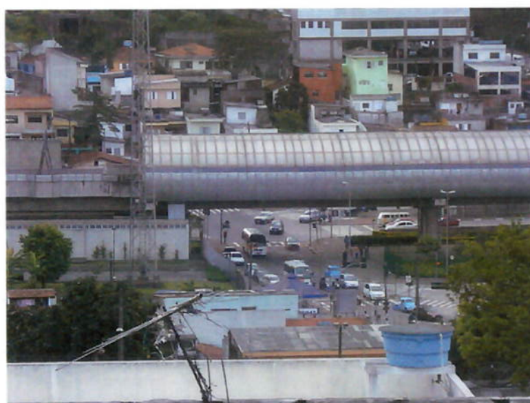
Figura 4.4.1 – Vista externa da Linha de Metrô do Campo Limpo
