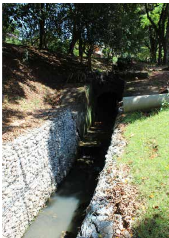
FIGURA 39. Local onde o Córrego das Corujas sai da galeria de concreto e passa a percorrer a céu aberto. Possível observar as chegadas de canos e outras drenagens.
