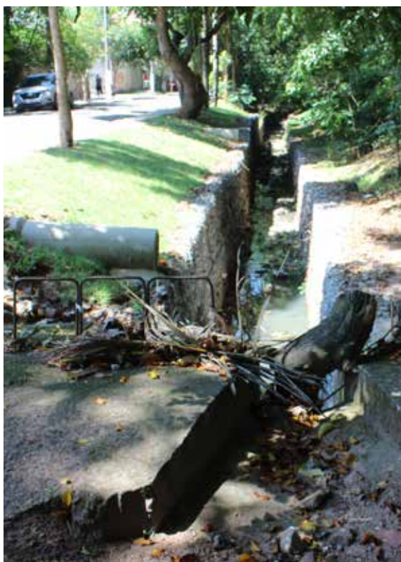
FIGURA 39. Local onde o Córrego das Corujas sai da galeria de concreto e passa a percorrer a céu aberto. Possível observar as chegadas de canos e outras drenagens.
