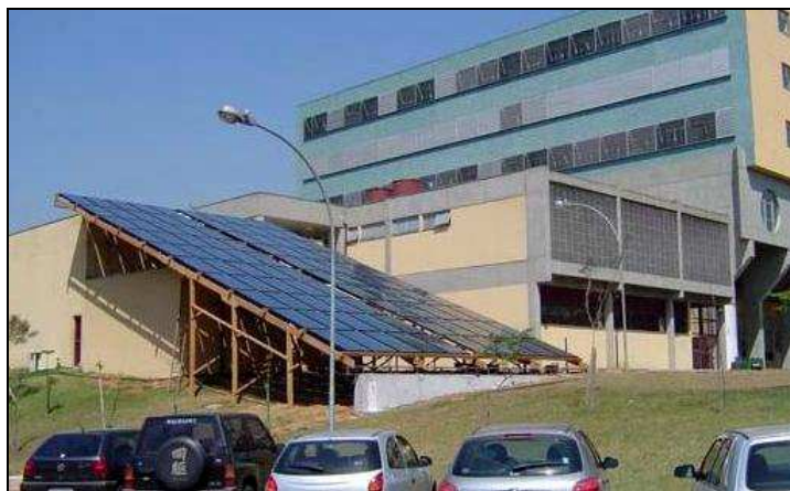
Figura 8 –As placas de aquecimento solar do Hospital Estadual Vila Alpina
