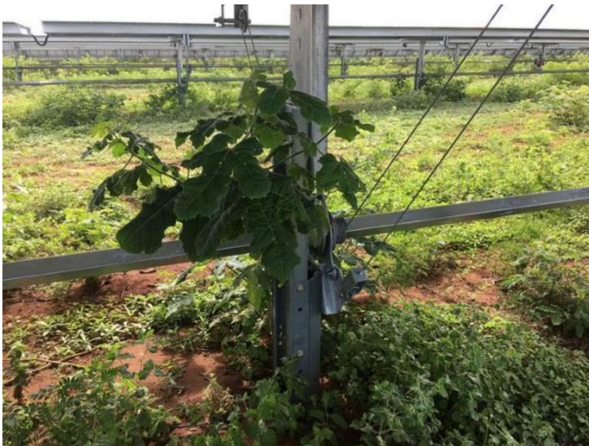
Figura 23 — Vegetação bloqueando a movimentação do rastreador
