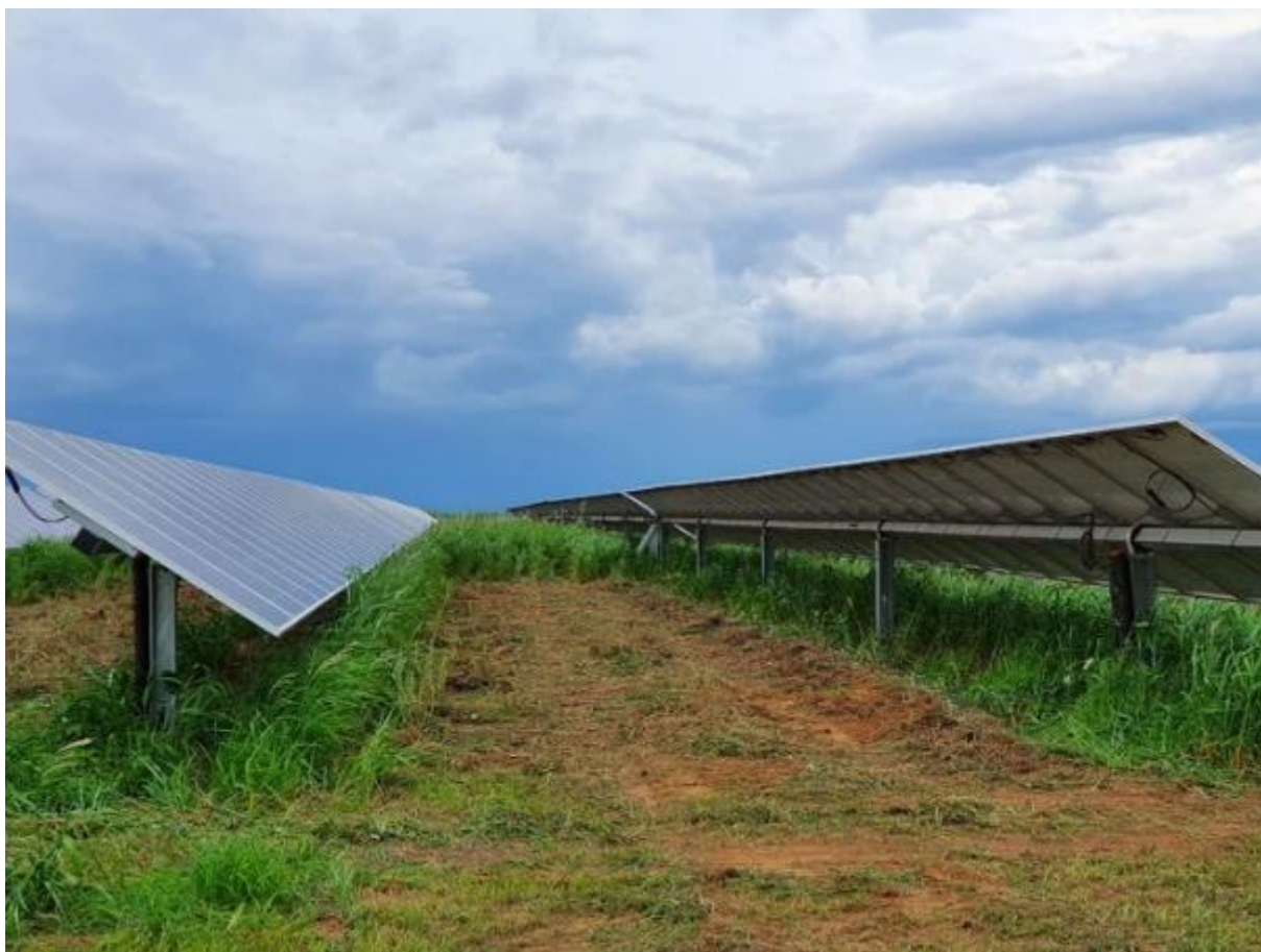
Figura 8 — Vegetação alta e sombreando os módulos – exemplo
