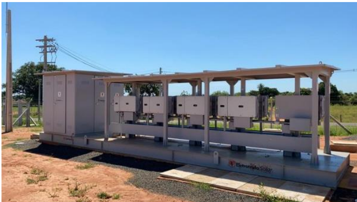
Figura 30 — Instalação dos inversores no SKID
