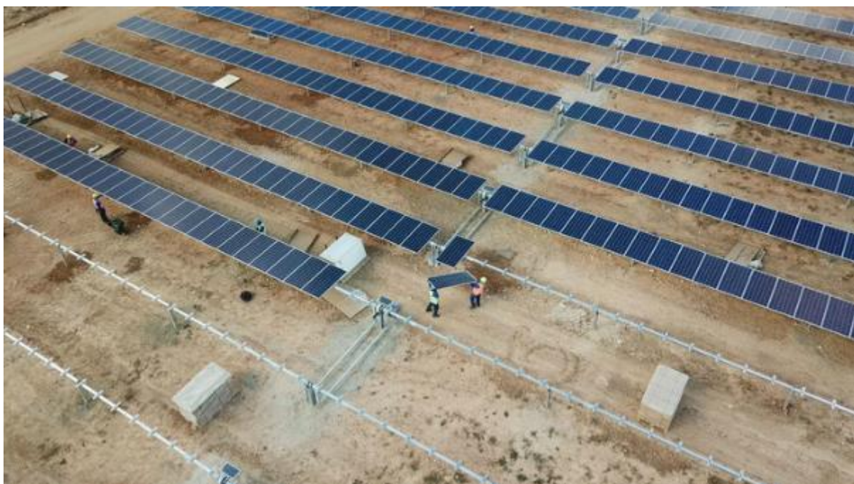
Figura 22 — Montagem de rastreadores solares Fonte: STi Norland (2020)
