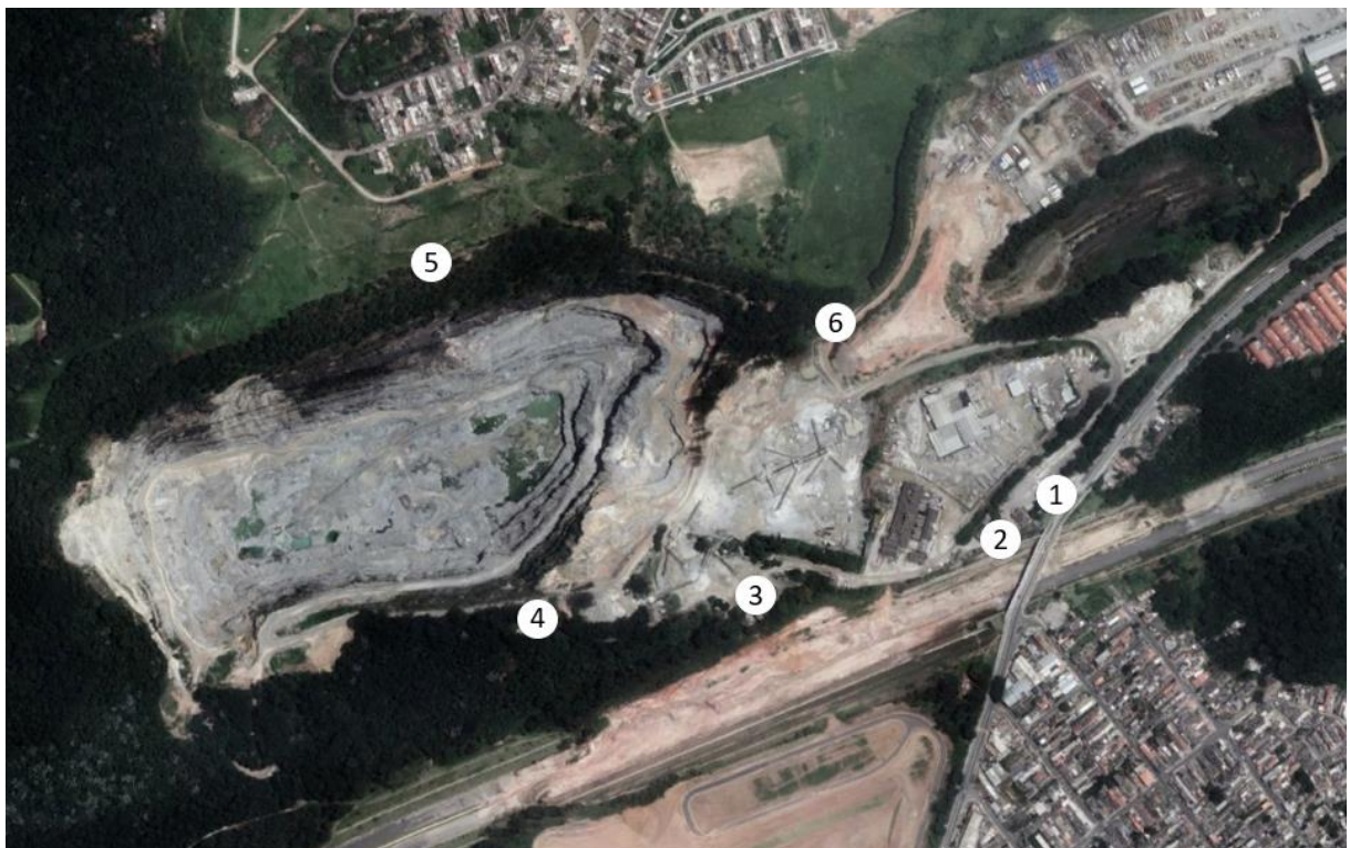
Figura 5 – Pontos de instalação do sismógrafo.
