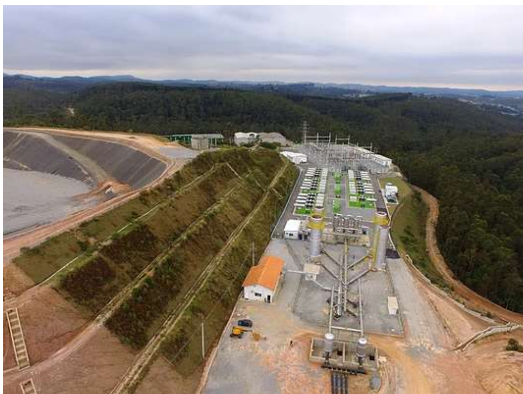
Figura 5 - Usina Termoverde Caieiras
