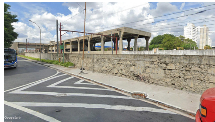
VISTA DO MURO PARALELO A FERROVIA
