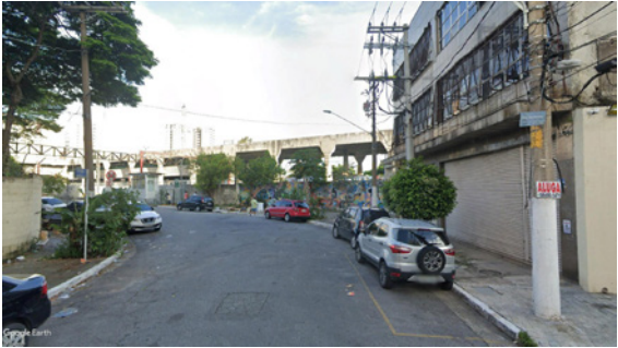
VISTA PARA ESTAÇÃO DA RUA DO HIPÓDROMO
