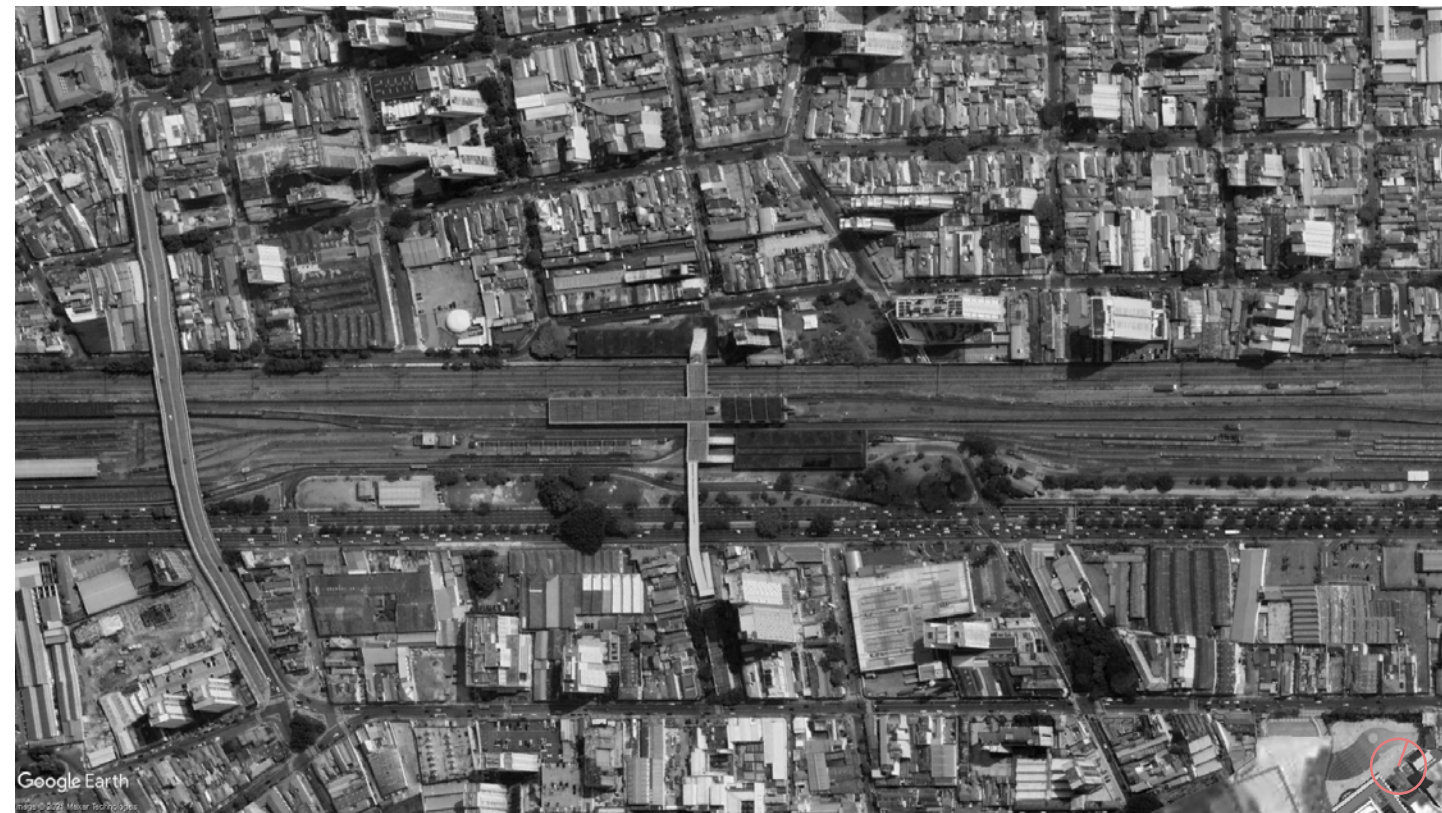
IMAGEM DE SATÉLITE | SITUAÇÃO ATUAL ESTAÇÃO BELÉM Fonte: Google Earth
