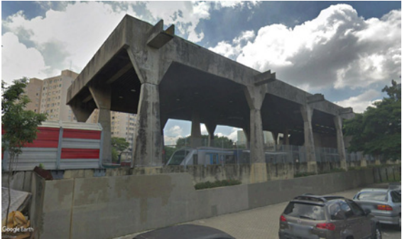
VISTA DA ESTRUTURA DA ESTAÇÃO BRESSER-MOÓCA
