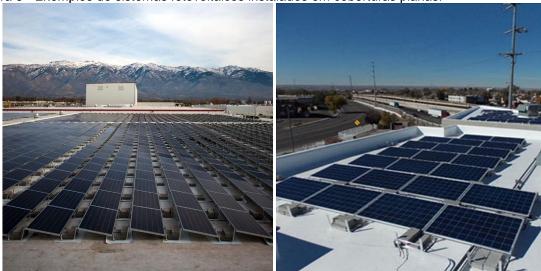
Figura 9 - Exemplos de sistemas fotovoltaicos instalados em coberturas planas.
