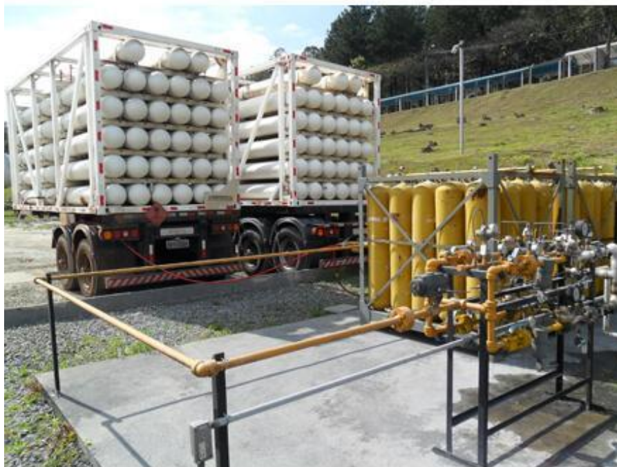
Figura 3.5. Carretas especiais com cestas de cilindros para transporte do GNC. Fonte: Logás, 2019
