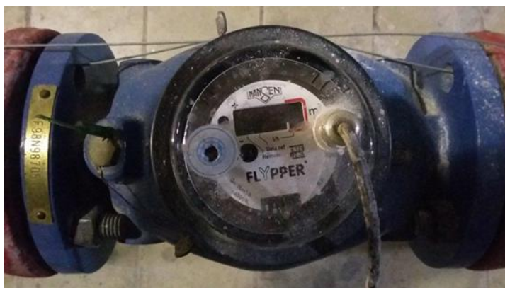
Figura 16 – Exemplo de hidrômetro com sensor eletrônico acoplado
