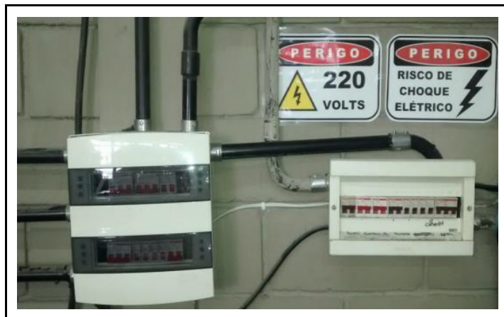
Figura 5 - Quadro elétrico com sinalização de advertência.
