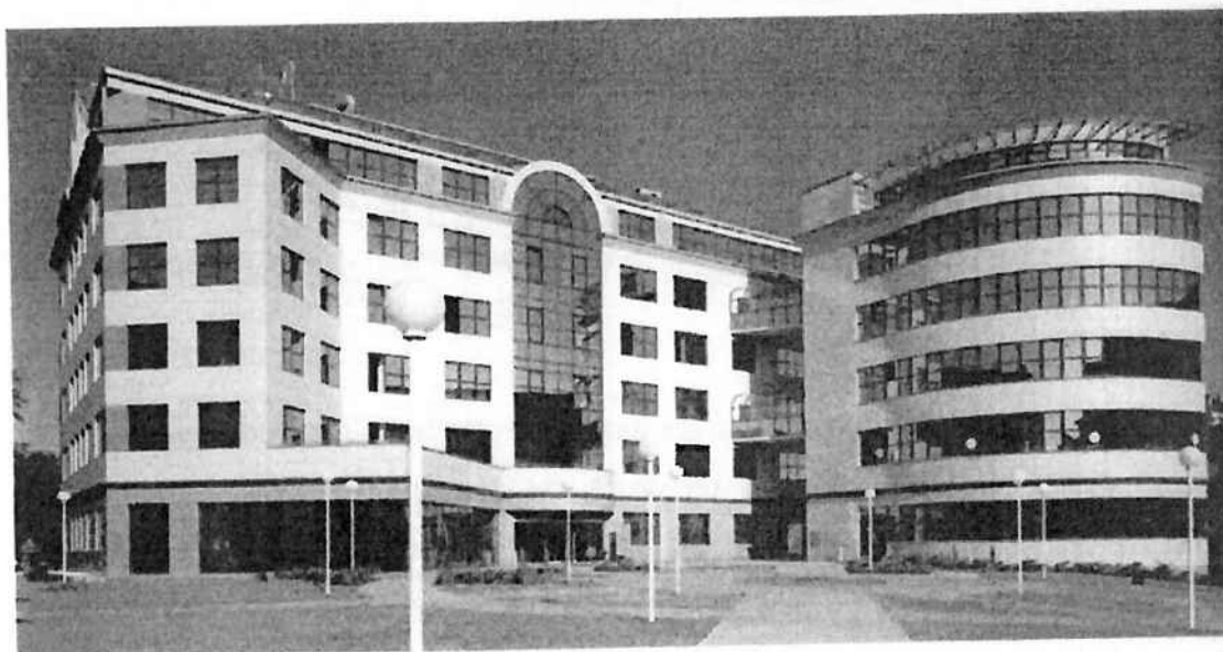
FIGURA 2.8: Edifício com fachada ventilada executada em cerâmica - Fonte MARAZZI (1997)
