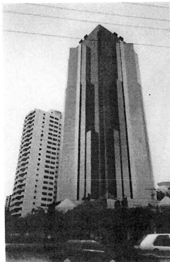
FIGURA 4.5 Aspecto de edifício em pele de vidro executado com fita adesiva - Alameda Mamoré - Alphaville Empresarial - Barueri
