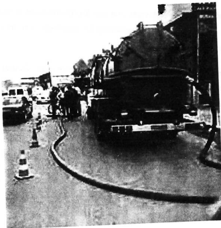
Figura 17 - Recolhimento de água/gasolina com caminhão-vácuo em galeria subterrânea.
