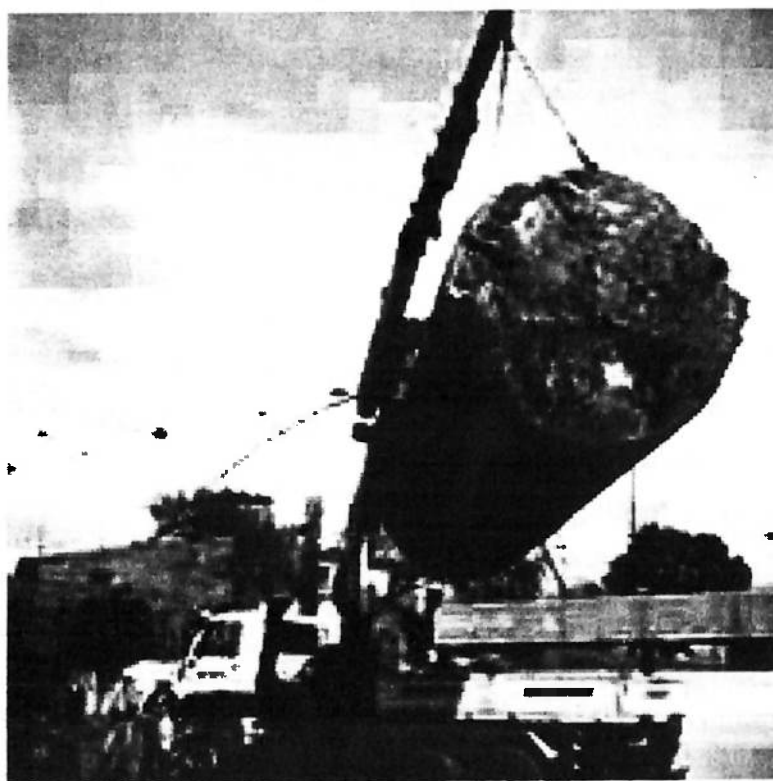
Figura 19 - Remoção de tanque avariado
