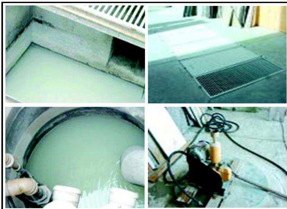
Figura 5 – Sistema de Decantação e Reuso de Água. Fonte: Santos et al , 2008.
