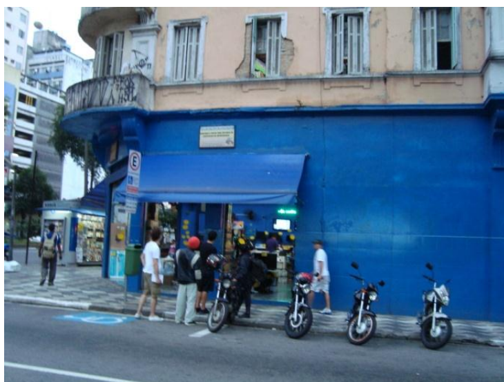
Figura 9.4 - Fachada do prédio expondo esquadrias de madeira.
