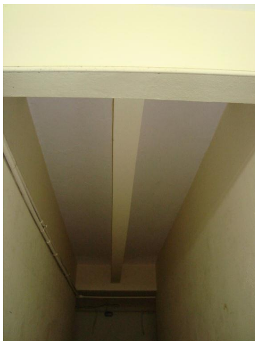
Figura 9.3 - Viga exposta no segundo pavimento sem sinais de patologias.
