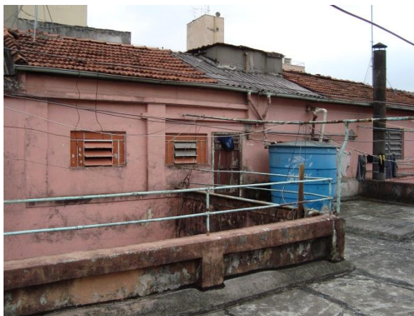
Figura 9.18 - Vista do telhado
