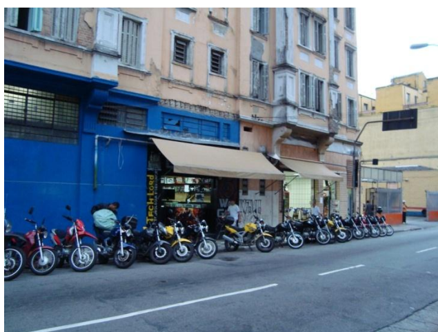
Figura 9.2 - Fachada lateral vista pela Rua Timbiras.
