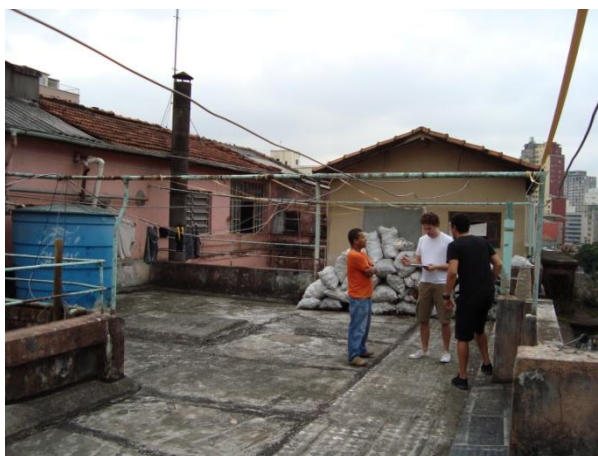
Figura 9.17 - Laje de cobertura.
