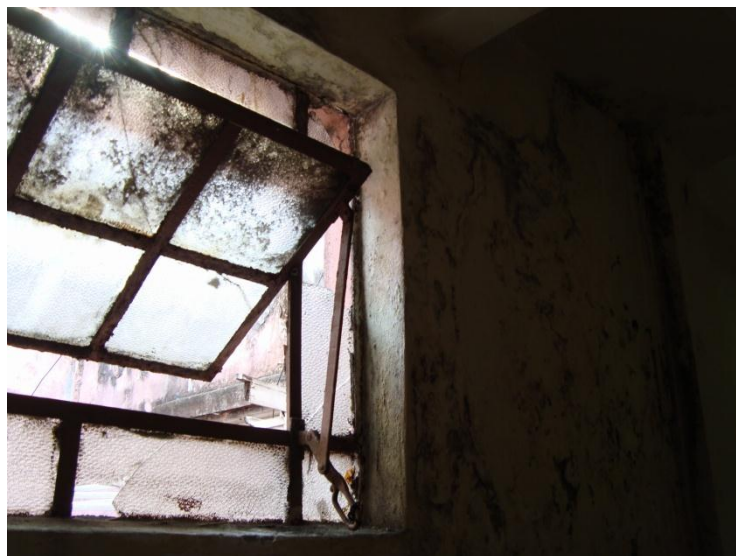
Figura 9.5 - Esquadria em aço.
