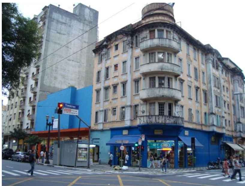
Figura 9.6 - Fachada do edifício.
