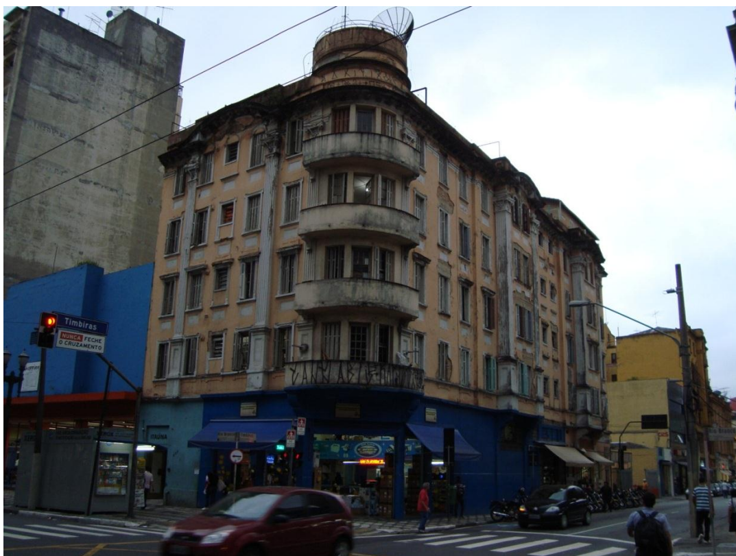
Figura 5.5 - Fachada atual do edifício
