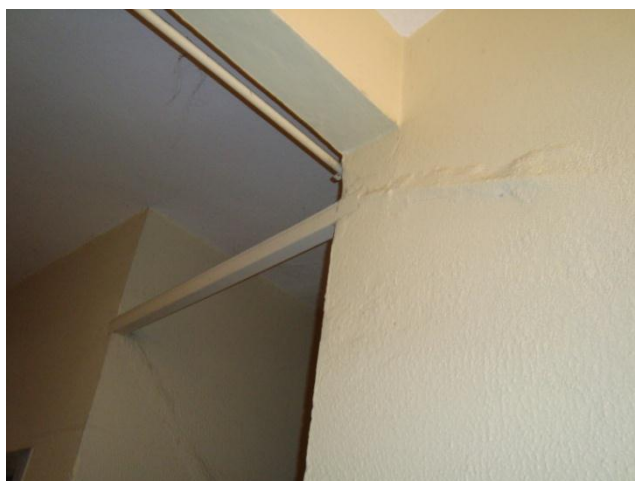
Figura 9.21 - Improviso de passagem de dutos elétricos entre vãos.
