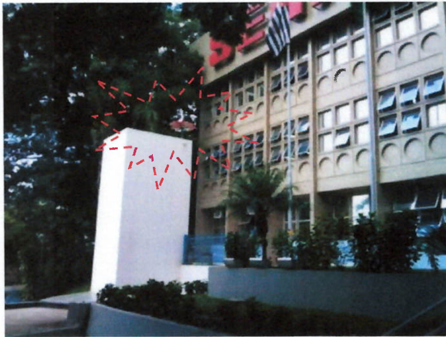
figura 06 - Mostra a obra executada com o Poste de Iluminação Instalado.
