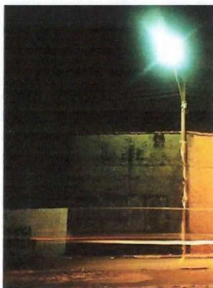
Figura 7 – Sistema de IP utilizando lâmpada a vapor de mercúrio
