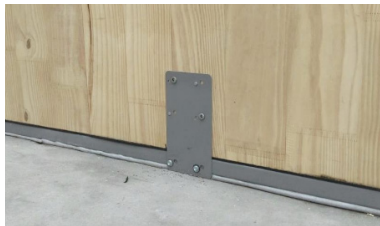
Conexão de elementos em CLT na fundação de concreto por meio de perfis e chapas metálicos.
