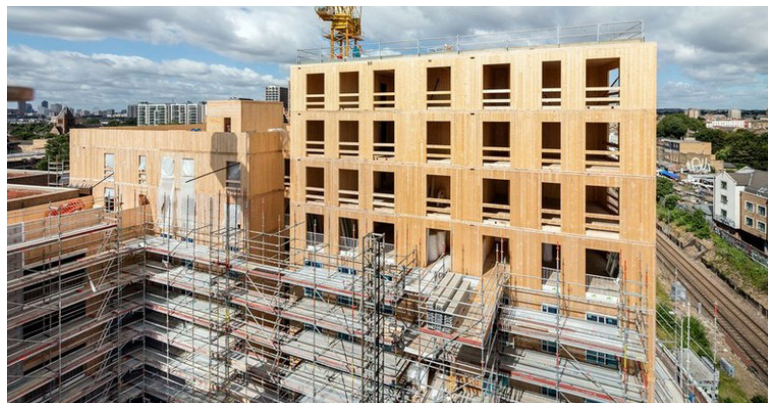
Dalston Works em obras evidenciando a estrutura de madeira. Fonte: Archdaily
