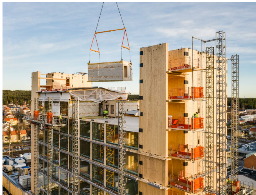
Posicionamento e fixação dos módulos do hotel entre Core de circulação desenvolvido em CLT. Fonte: White arkitekter website
