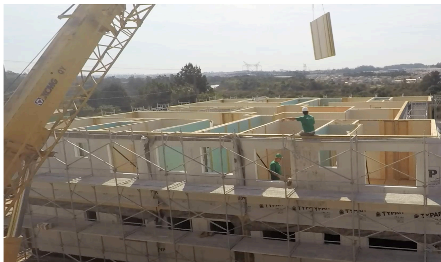
Construção de um edifício utilizando Wood Frame como principal método construtivo. Fonte: Tecverde, 2021
