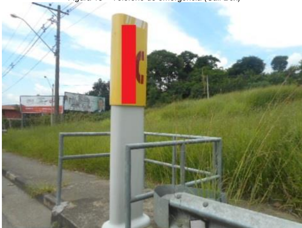
Figura 13 – Telefone de emergência ( Call Box )
