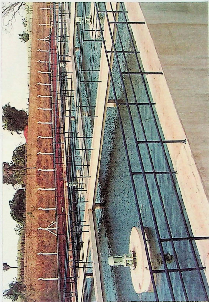
Foto 9 - Tanque de Aeração e Aeradores (ETE IV)
