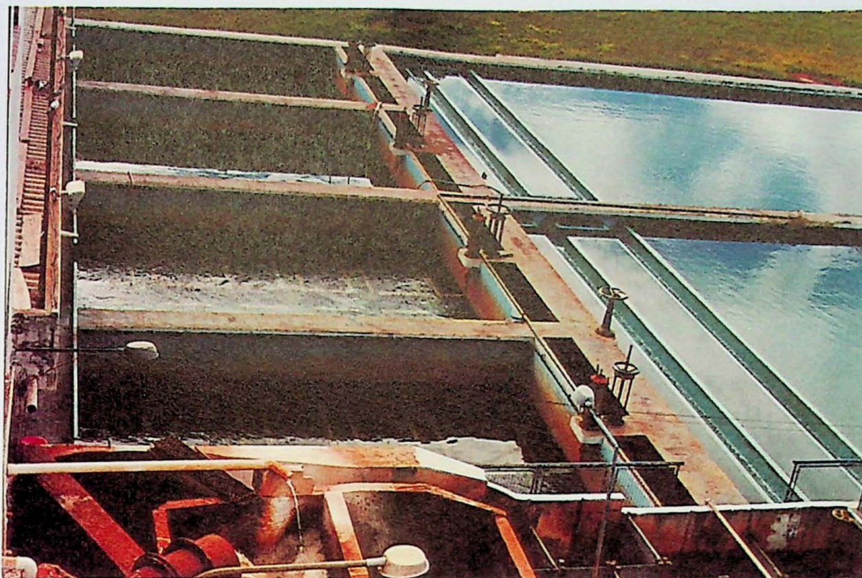
Foto 3 - Filtros e Piscinas de Decantação (ETA Pereira)
