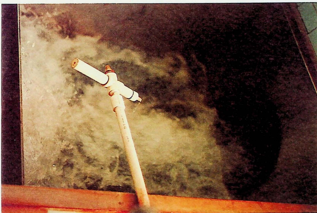
Foto 6 - Vazão do poço ( 500\text{m}^3/\text{h} ) e aplicação de hipoclorito de sódio
