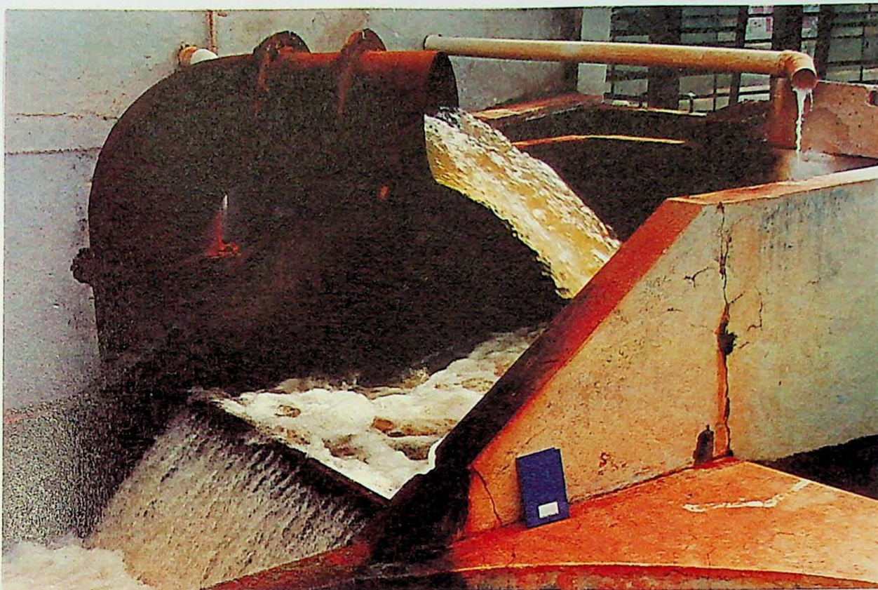
Foto 01 - Água bruta ( Q = 800\text{m}^3/\text{h} ), Cal e grade.
