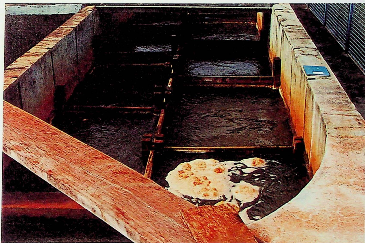
Foto 02 - Chicanas (fluxo lento - floculação)
