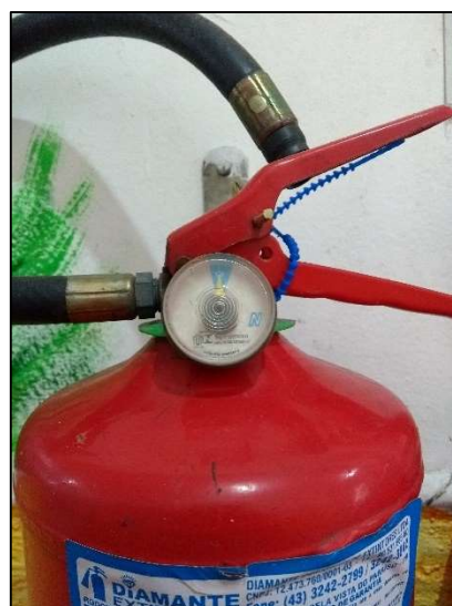
Figura 41 - Carga dos extintores
