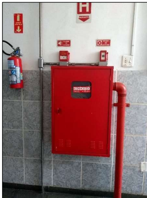
Figura 67 - Hidrante do pavimento superior Bloco 2
