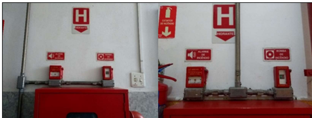
Figura 45 - Acionador manual de emergência
