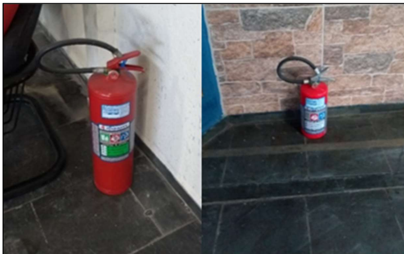
Figura 42 - Extintor irregular
