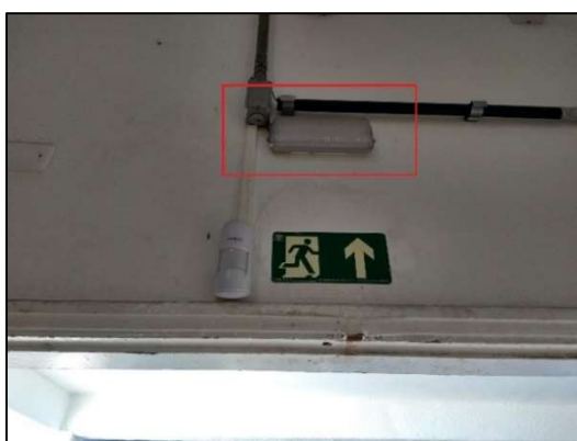
Figura 43 - Iluminação de emergência sobre saídas
