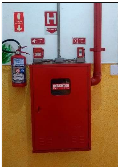
Figura 66 - Hidrante do pavimento térreo Bloco 2
