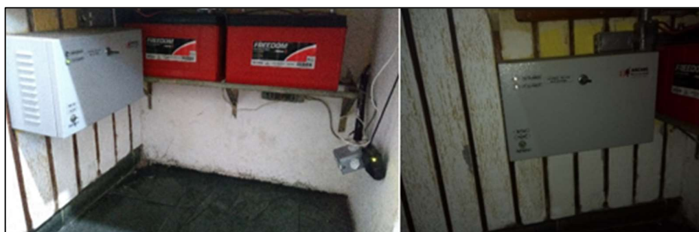
Figura 46 - Central de Alarme
