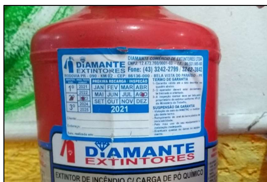
Figura 40 - Data de manutenção dos extintores
