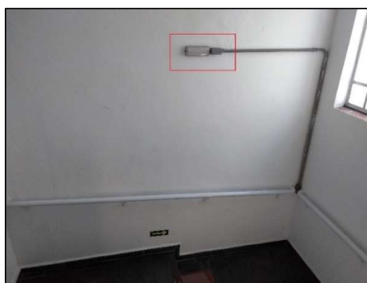
Figura 44 - Iluminação de emergência sobre escadas
