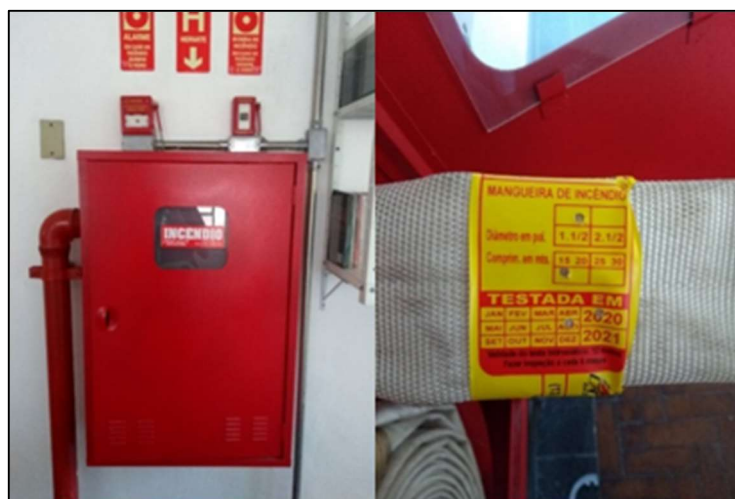
Figura 64 - Hidrante do pavimento superior Bloco 1
