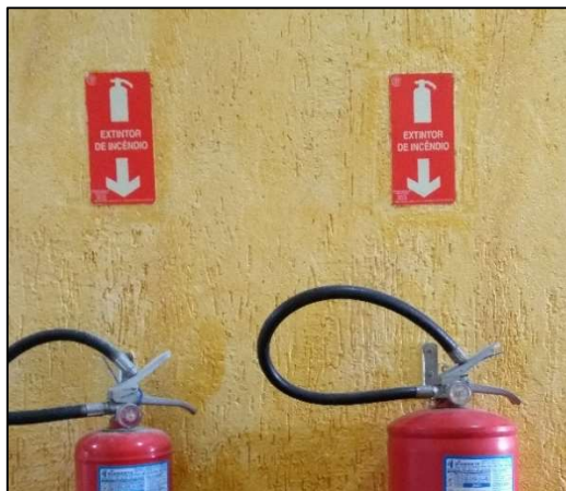
Figura 48 - Sinalização de equipamentos de combate a incêndio
