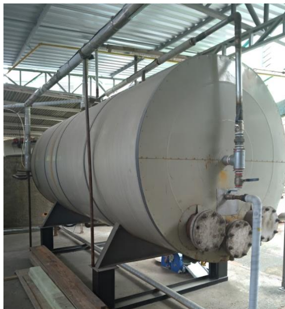
Figura 4.6 - Sistema de água quente atual
