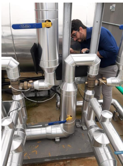
Figura 4.11 - Válvulas desviadoras a saída da acumulação de água quente
