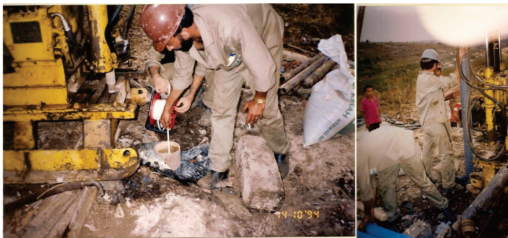
Figura 19 - Instalação de Poço de Monitoramento. (DLU, 1994).
