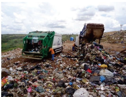
Figura 1 - Descarga de resíduos na frente de operação do aterro sanitário Delta A, Campinas - SP (TECAM, 2013).
