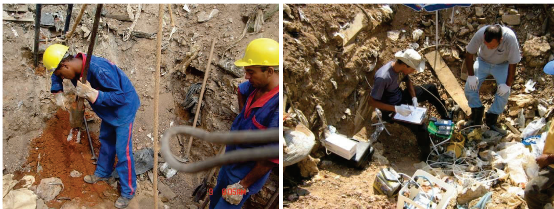
Figura 29 - Sondagem para instalação de PM e amostragem de água subterrânea por baixa vazão. (DLU, 2008).
