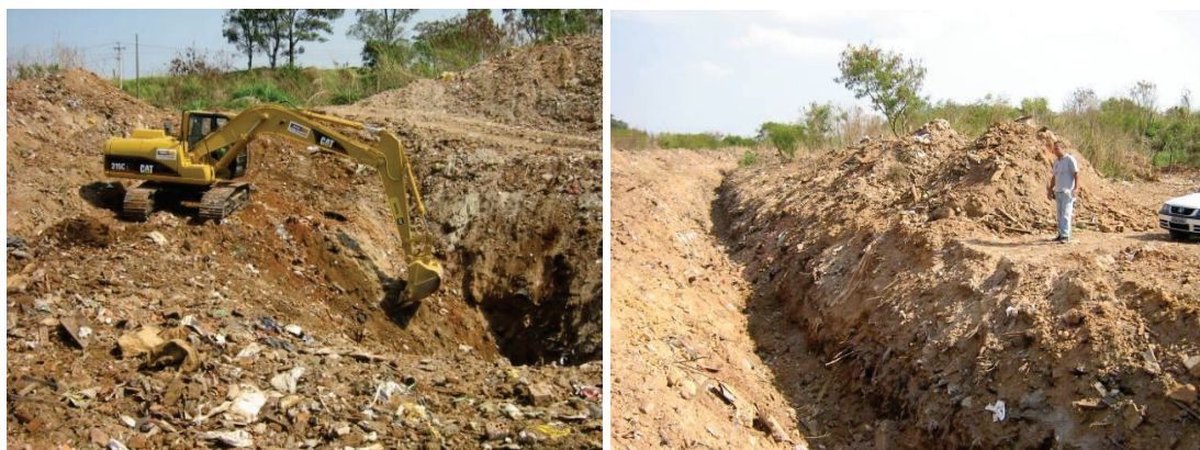
Figura 28 - Abertura de trincheira. (DLU, 2008).
