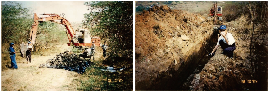
Figura 26 - Abertura de trincheiras. (DLU, 1994).
