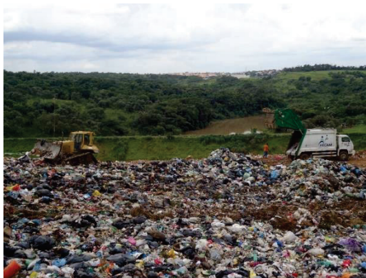
Figura 2 - Espalhamento dos resíduos descarregados na frente de operação do aterro sanitário Delta A, Campinas - SP (TECAM, 2013).
