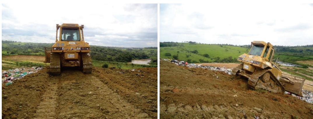
Figura 3 - Cobertura dos resíduos descarregados na frente de operação do aterro sanitário Delta A, Campinas - SP (TECAM, 2013).
