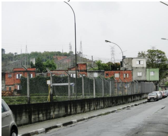
Foto 5 - Favela Pantanal, esquina com o complexo administrativo da Bayer
