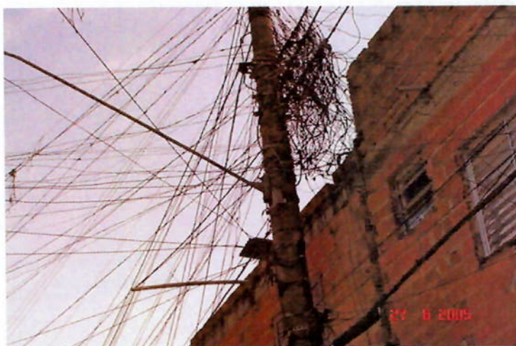
Figura 19 – Pontos de conexão irregular (AES Eletropaulo)
