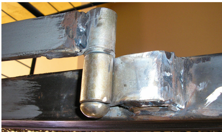
Figura 45: Detalhe da articulação do braço de fixação do eixo.
