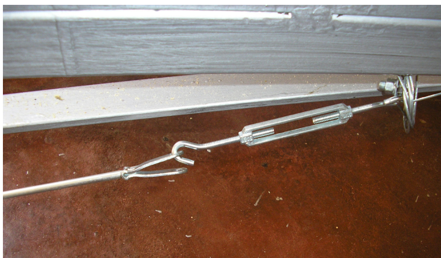
Figura 66: Esticador do cabo de aço.
