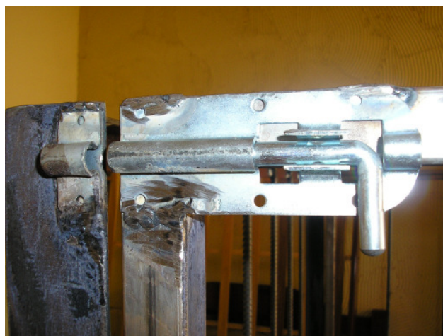
Figura 49: Detalhe do trinco instalado nos quadros articulados (superiores).
