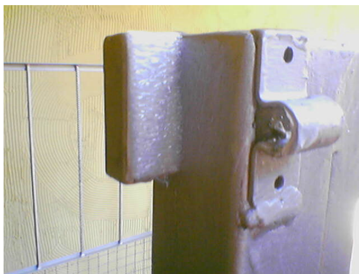
Figura 71: Detalhe do batente do quadro superior esquerdo após a aplicação do polímero.
