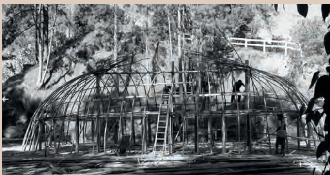
Figura 14 - A casa da Oca de Xingu em construção. ↓
