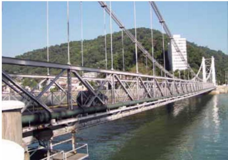
Figura 25 - Exemplo de ponte com plataformas móveis para inspeção.
