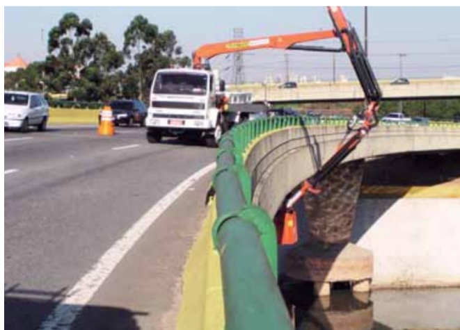
Figura 24 - Caminhão realizando uma inspeção (interdição de duas faixas de tráfego).
