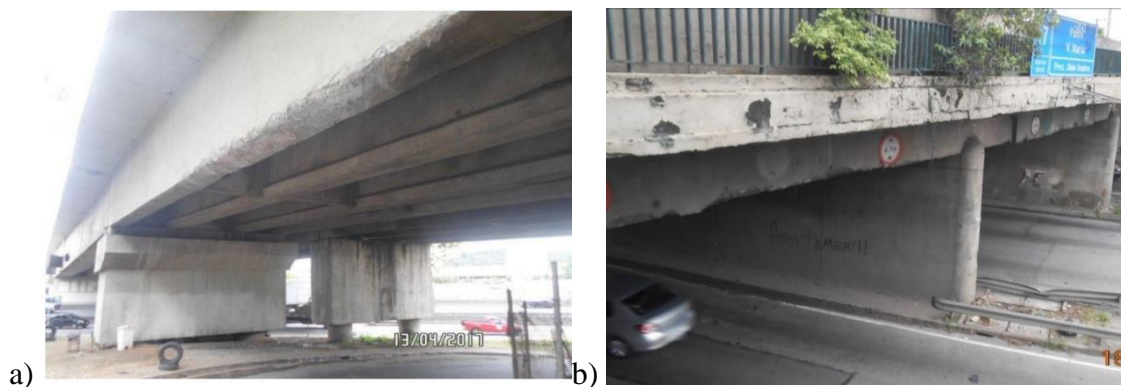
Figura 17 - Exemplos de pontes com desagregação de concreto. (a) Ponte dos Remédios (viga longarina com armadura exposta e corroída). (b) Ponte Presidente Jânio Quadros.
