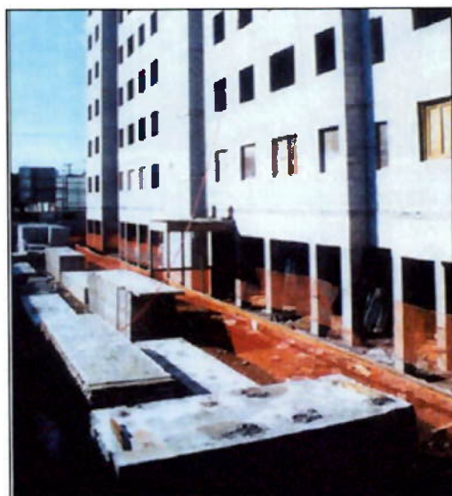
Foto 2 – Estoque das lajes pré moldadas no canteiro de obras Fonte: IBTS.
