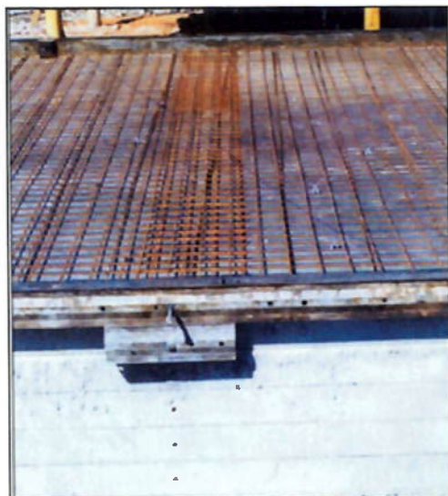
Foto 1 – Forma metálica para moldagem da laje Fonte: IBTS.
