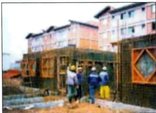
Foto 3 – Forma metálica para paredes de concreto Fonte: IBTS.
