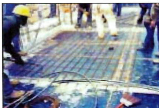
Foto 4 – Concretagem em formas metálicas Fonte: IBTS.
