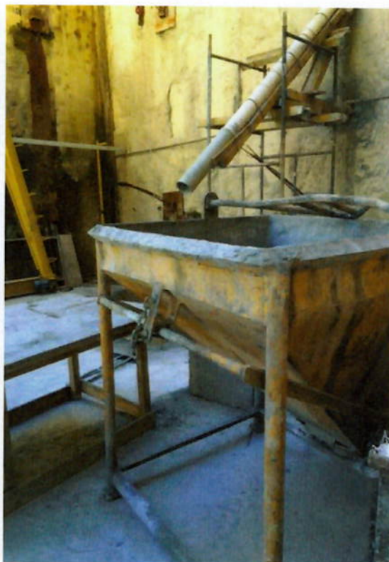
Foto 6.3: Caçamba para transporte do concreto (Fonte: Autora)
