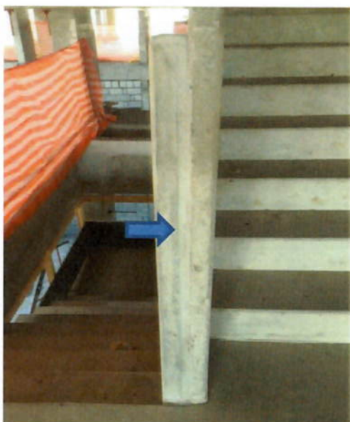
Foto 8.1: Acabamento entre as muretas da escada (Fonte: Autora)
