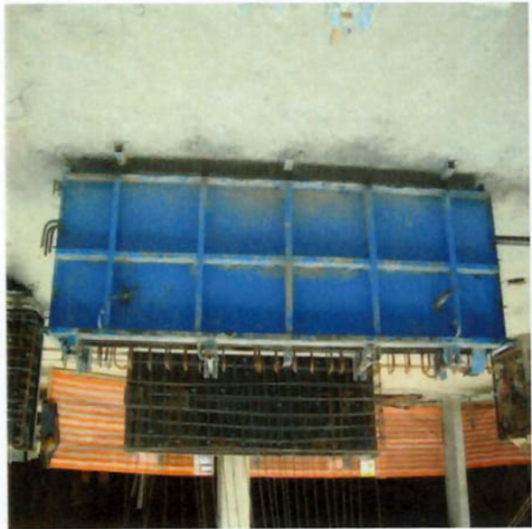
Foto 4.1: Formas das vigas da escada (V629/V623A) (Fonte: Autora)
