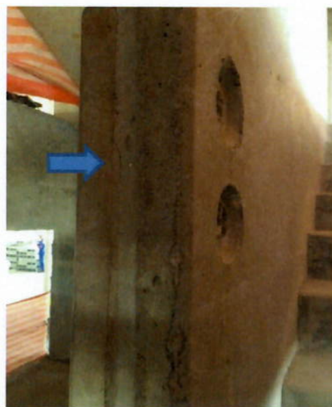
Foto 8.2: Trinca no acabamento entre as muretas da escada (Fonte: Autora)
