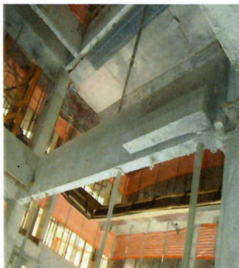
Foto 4.5: Vigas da escada instalada (V656A) (Fonte: Autora)
