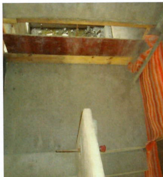
Foto 4.12: Patamar 2 da escada instalado (Fonte: Autora)
