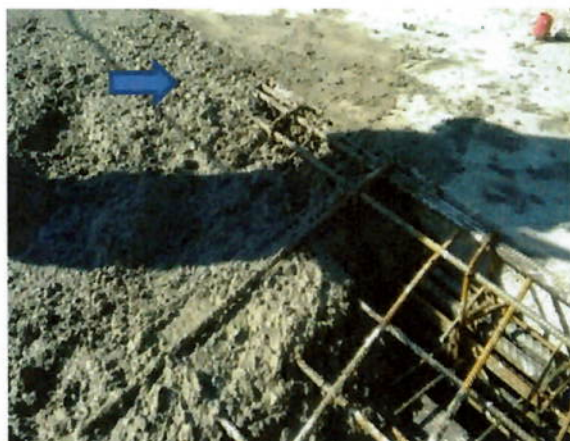
Foto 8.7: Cobrimento do concreto entre sacada pré-moldada e viga (Fonte: Autora)
