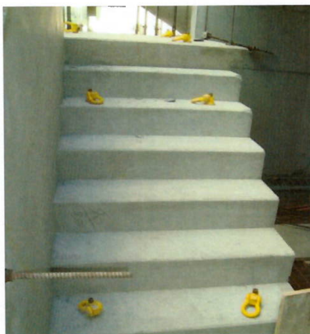
Foto 4.15: Lance 1 da escada instalado (Fonte: Autora)
