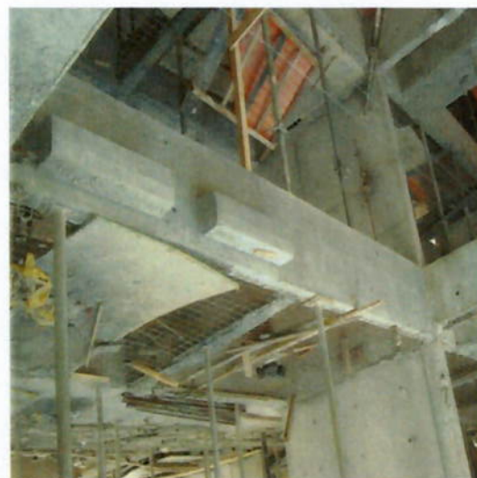
Foto 4.4: Vigas da escada instalada (V659A) (Fonte: Autora)
