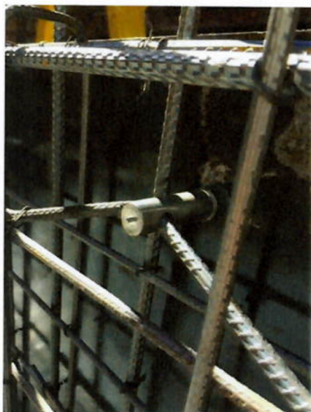
Foto 6.11: Inserto de içamento posicionado na forma (lado interno) - (Fonte: Autora)
