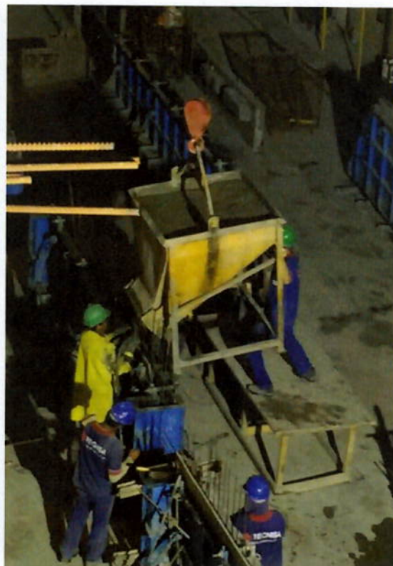
Foto 6.5: Descarga do concreto na forma metálica (Fonte: Autora)
