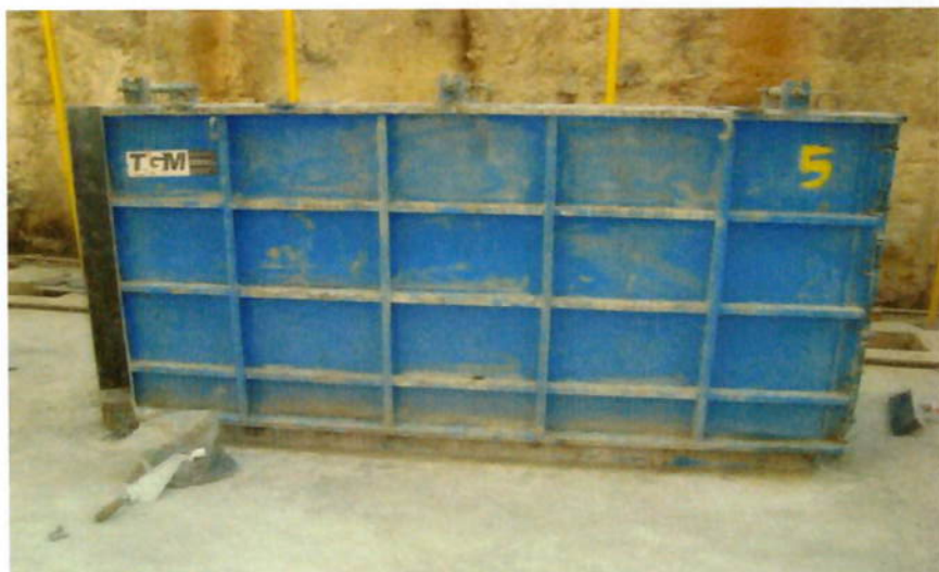
Foto 4.13: Forma do lance 1 e do lance 2 da escada (Fonte: Autora)
