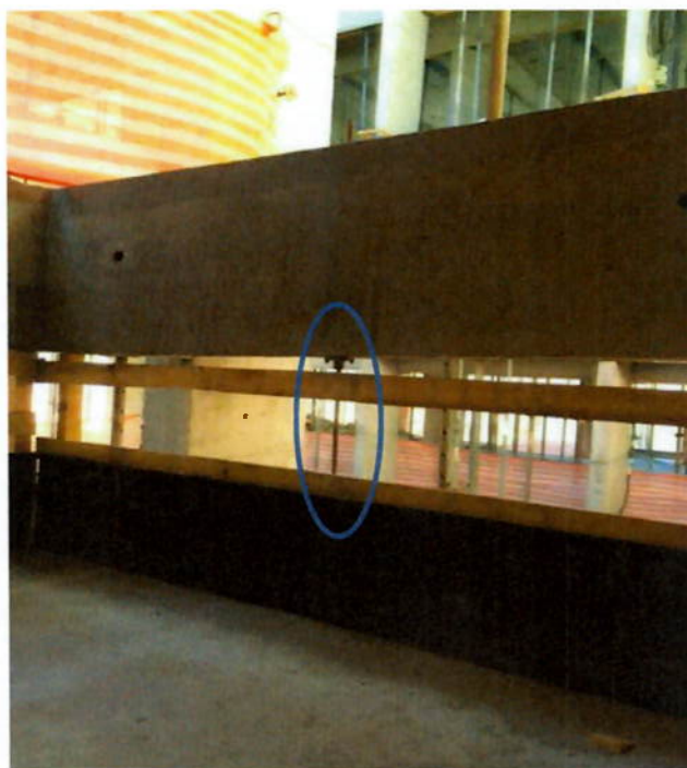
Foto 8.9: Barra de ancoragem permanente para sustentação da escada (Fonte: Autora)
