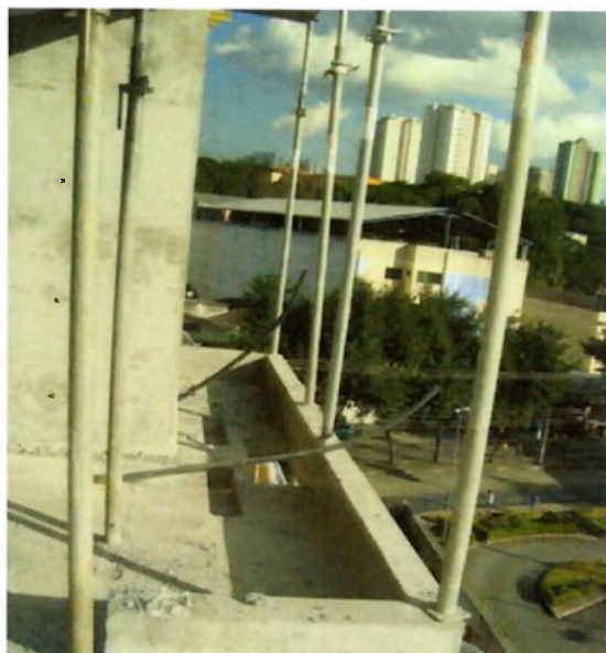
Foto 5.7: Sacada 1A instalada, com o escoramento remanescente aplicado (Fonte: Autora)
