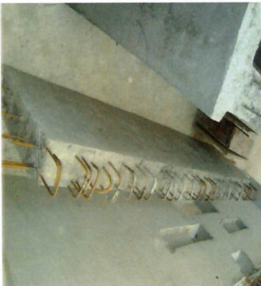
Foto 4.2: Estocagem da viga da escada (V623A) (Fonte: Autora)
