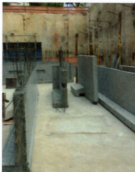
Foto 6.7: Posicionamento dos elementos após desforma (Fonte: Autora)
