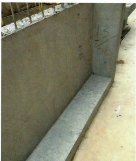
Foto 6.8: Impactos da concretagem na posição vertical – formação de bolhas (Fonte: Autora)
