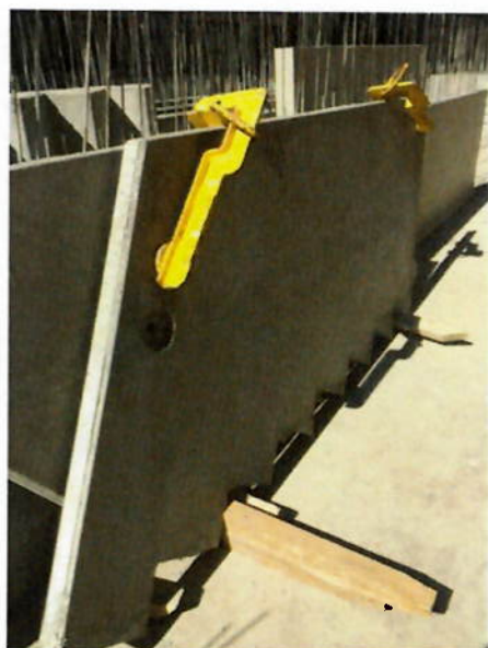
Foto 6.13: Acessório para içamento preso ao inserto (Fonte: Autora)
