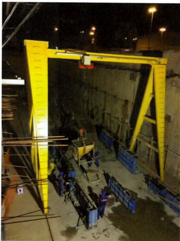
Foto 6.4: Transporte da caçamba pelo pórtico (Fonte: Autora)
