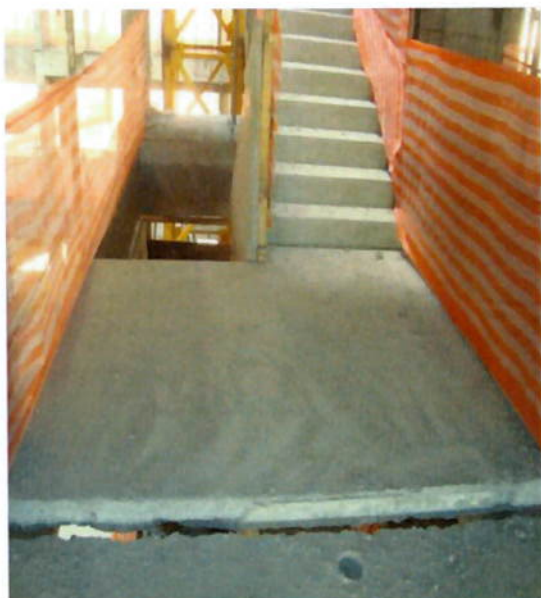
Foto 4.11: Patamar 1 da escada instalado (Fonte: Autora)
