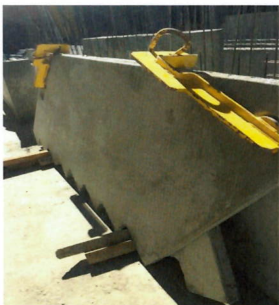
Foto 4.17: Estocagem da forma da mureta da escada (Fonte: Autora)
