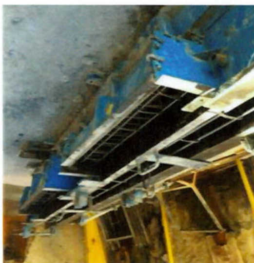
Foto 4.7: Detalhe da Forma do console das vigas da escada (V656/V659A) – (Fonte: Autora)
