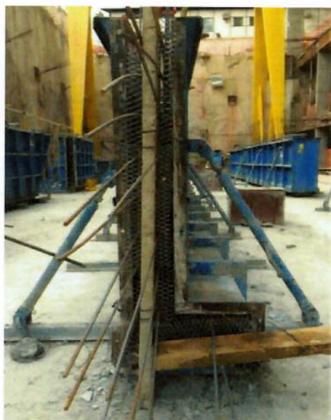
Foto 6.6: Posição da forma para concretagem (Fonte: Autora)
