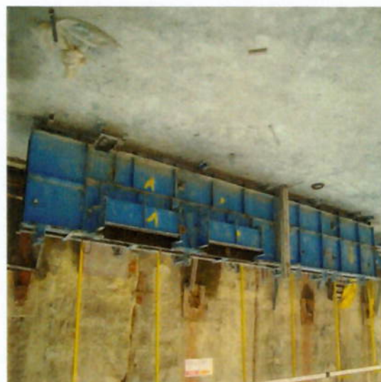
Foto 4.6: Forma das vigas da escada (V656/V659A) (Fonte: Autora)
