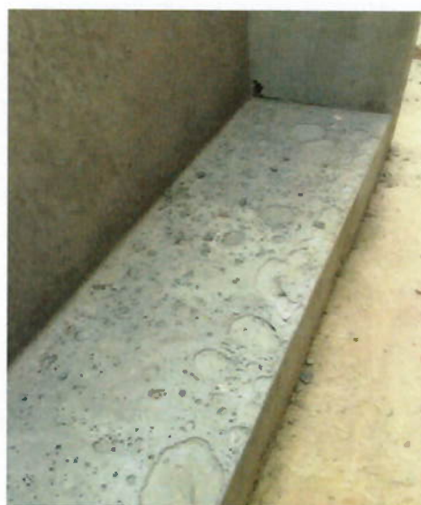
Foto 6.9: Ampliação das bolhas (Fonte: Autora)
