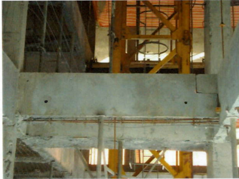
Foto 4.3: Vigas da escada instalada (V623A) - (Fonte: Autora)
