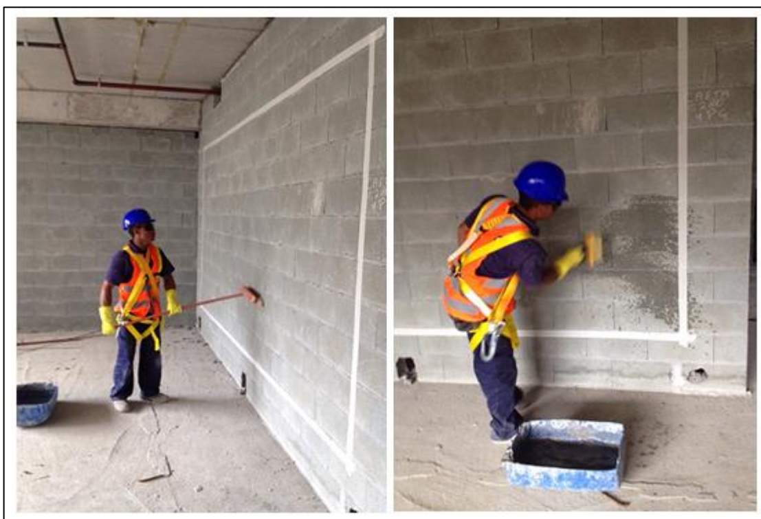
Figura 8 - Limpeza da base com vassoura e broxa úmida para retirar as impurezas.
