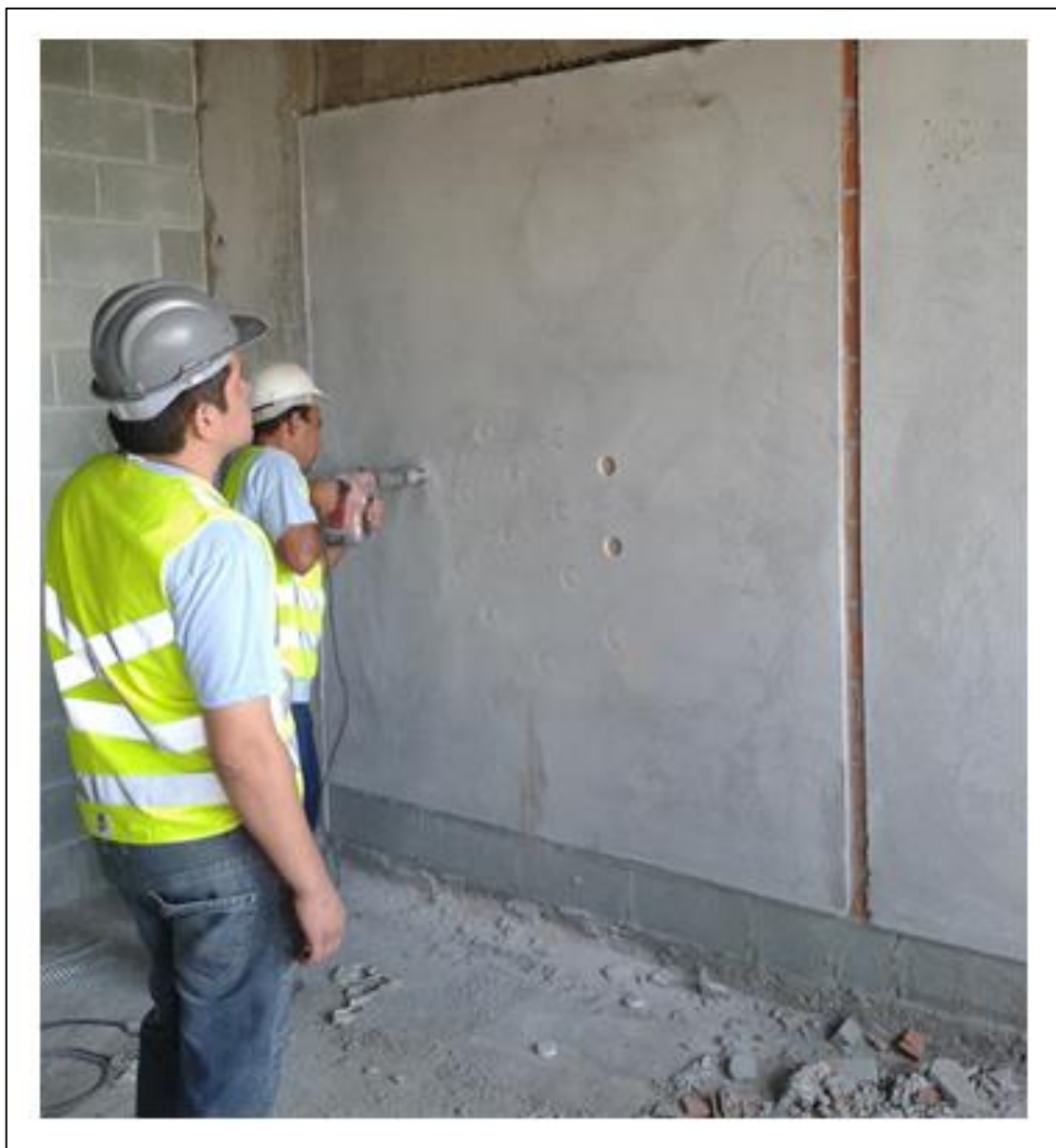
Figura 19 – Execução dos furos no painel.
