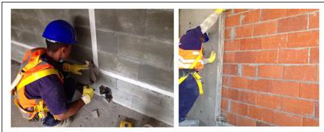
Figura 13 - Execução das taliscas.
