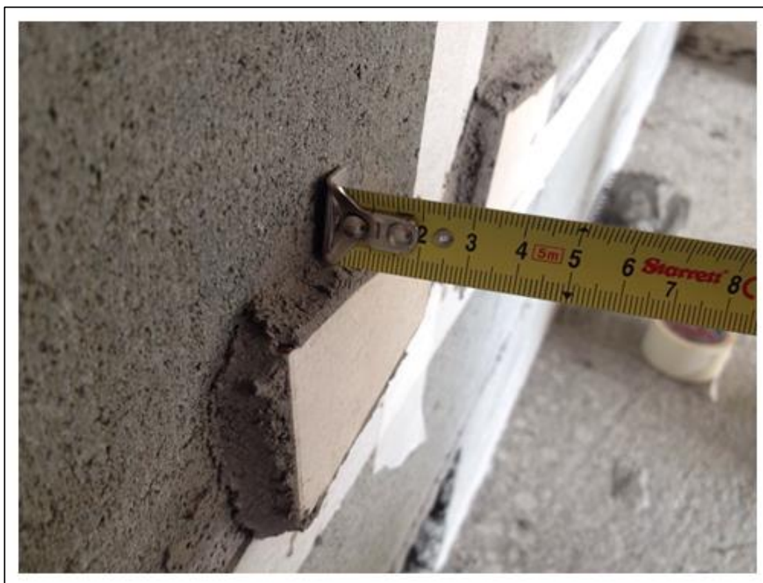
Figura 14 - Inspeção da espessura da argamassa no painel.
