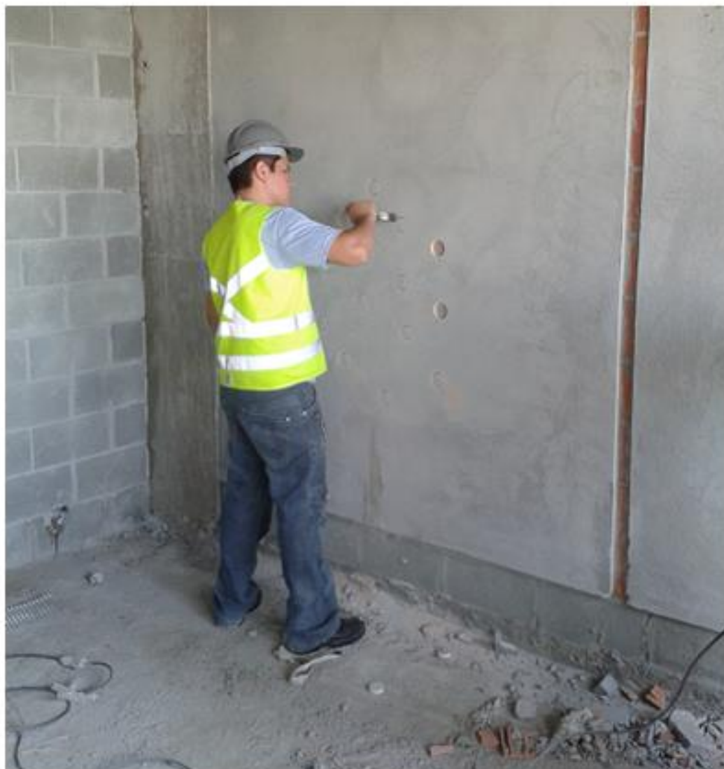
Figura 20 - Limpeza dos furos.
