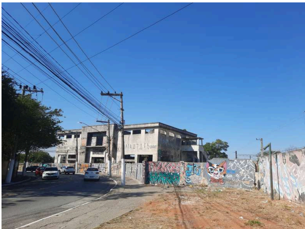
Figura 19: Antiga Sede do Clube Social, agora em profundo abandono, 2025.
