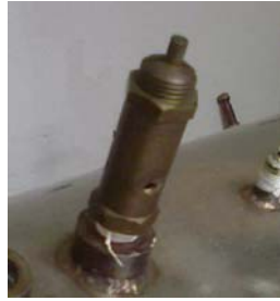
Figura 22: Válvula de segurança.
