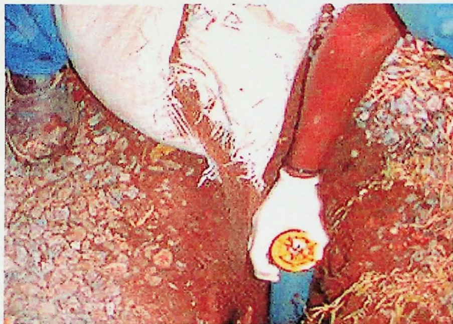
Foto 8 – Colocação do pré-filtro (areia).
