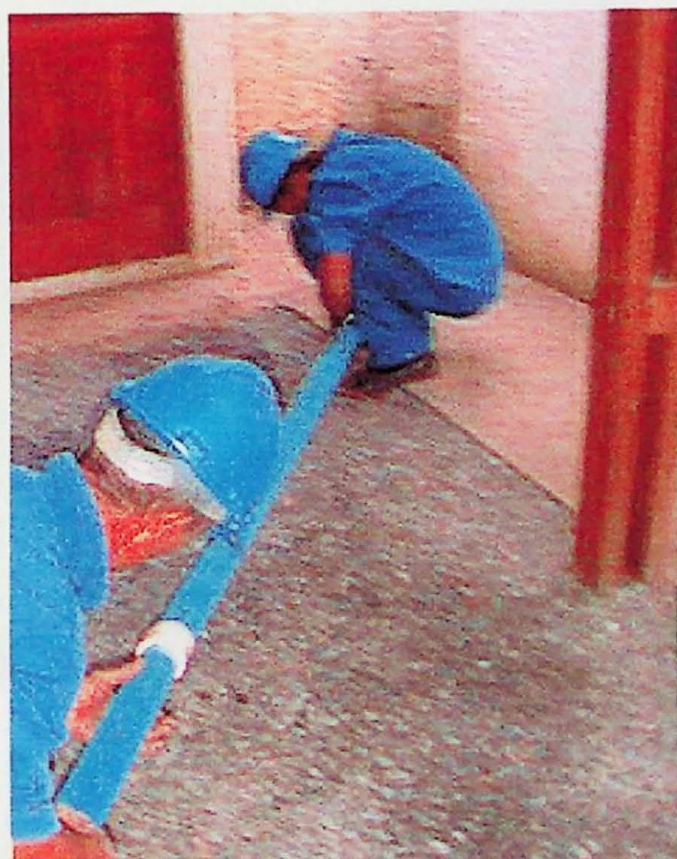
Foto 6. Montagem do revestimento juntamente com o filtro.
