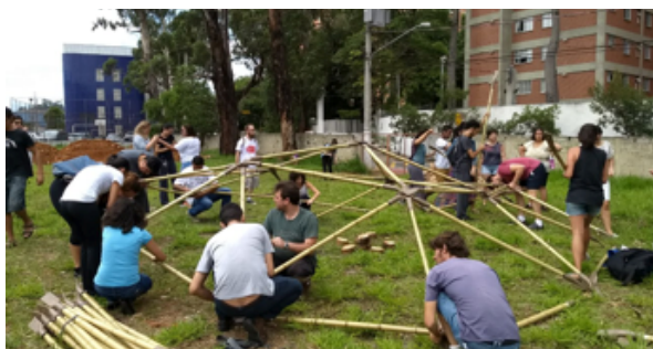
Figura 66. Montagem da porção superior da estrutura. Foto da autora.
