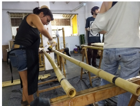
◀ Figura 53. Marcação das extremidades das varas com fitas. Foto da autora.
