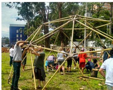
Figura 68. Reforço dos parafusos depois da estrutura montada. Foto da autora.
